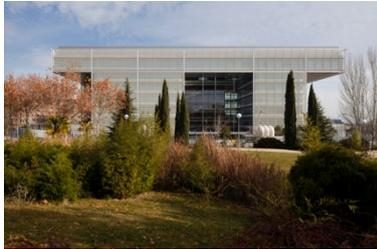
**Bild 4:** Die keramische Beschichtung der Solarreflektor-Rohre vor den Außen Fassaden fängt Licht ein und reflektiert es mit gedimmter Helligkeit ins Gebäudeinnere.
