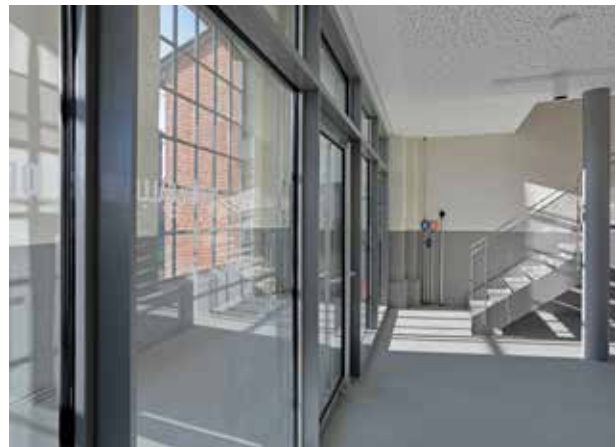
6382.jpg: Innenwand im Lokstand 1; gefertigt aus der Kombination von VISS-Linea Tragprofilen und Riegeln aus dem VISS Fassadensystem. Dahinter Janisol Arte 2.0-Industrieverglasungen.
