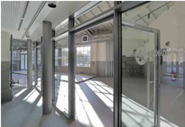
6521.jpg: Um die Raumwirkung zu erhalten (im Bild: Lokstand 6) wurden alle Einbauten, Trennwände und Türen als filigrane Stahl-Glaskonstruktionen mit Profilsystemen von Jansen realisiert.
