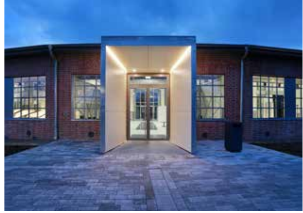
9608.jpg: Ein vorgesetzter Kubus fungiert als Windfang und Eingangsmarkierung. Die zweiflügelige Drehtüre mit Oberlicht wurde aus dem Stahlsystem Janisol von Jansen gefertigt.
