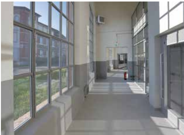
6406.jpg: Industrieverglasung im Lokstand 0 (links); gefertigt aus dem schlanken, thermisch getrennten Sprossensystem Janisol Arte 2.0. Mit Drehflügel, der zum Lüften geöffnet werden kann.
