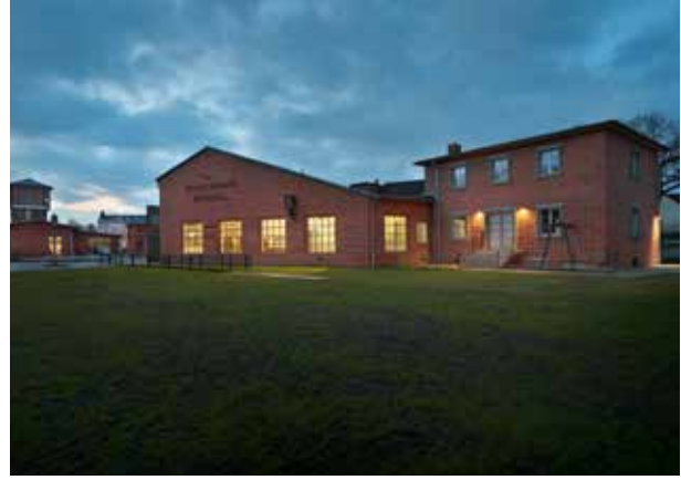
9592.jpg: Aussenansicht des Lokstands 7 (links), ebenfalls vollflächig mit einer Innendämmung versehen. Die schmalen Öffnungsflügel in der Verglasung sind kaum wahrnehmbar.
