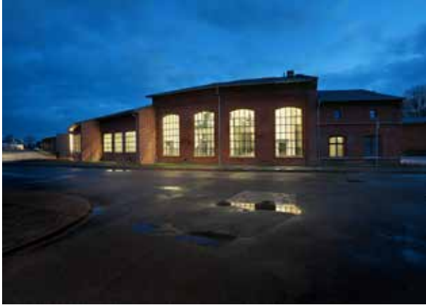
9574.jpg: Aussenansicht der Lokstände 0 und 1, die – innen vollflächig gedämmt – als Coworking Spaces genutzt werden. Die Industrieverglasungen wurden mit Janisol Arte 2.0 erneuert.
