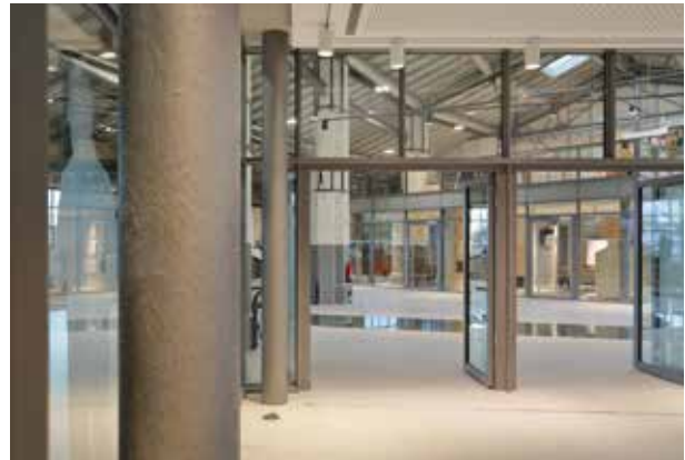
9856.jpg: Lokstand 2 mit Blick auf den eingeschossigen Kubus. Zwei zweiflügelige Türen aus der ungedämmten Serie Jansen-Economy 60 wurden optisch unauffällig in die VISS-Fassade integriert.
