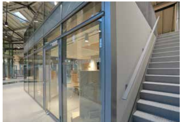
9781.jpg: Veranstaltungen und Workshops finden in den beiden klimatisierten Glaskuben statt. Hier wurden VISS-Linea Tragprofile mit Riegeln aus dem VISS Fassadensystem kombiniert.
