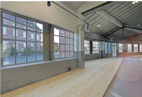
6357.jpg: Blick auf die Südfassade der grossen Lokschuppenhalle (Lokstände 2 – 6), die als „kalte“ Ausstellungshalle konzipiert ist. Industrierverglasungen aus Janisol Arte 2.0 von Jansen.
