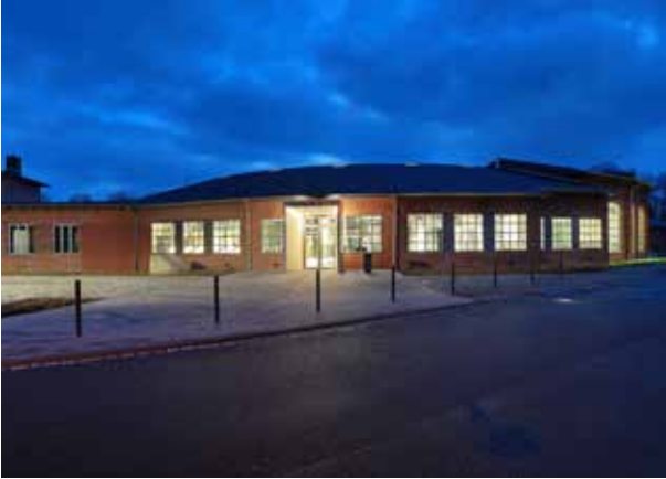
9562.jpg: Einer der wenigen, funktional bedingten Eingriffe in die Substanz ist die Neuausrichtung des Haupteingangs: Die Erschließung erfolgt nunmehr an der südlichen Fassadenseite.
