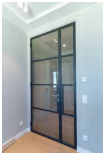
HGP03646.jpg: Einflügelige Drehtüre mit Seitenverglasung.
