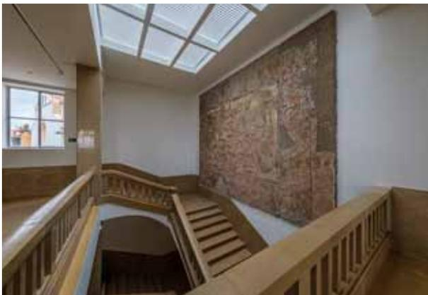
pic\_06 Eine wärmegegedämmte Konstruktion aus dem Stahlsystem VISS Dach ersetzt das einfach verglaste Dachoberlicht.
