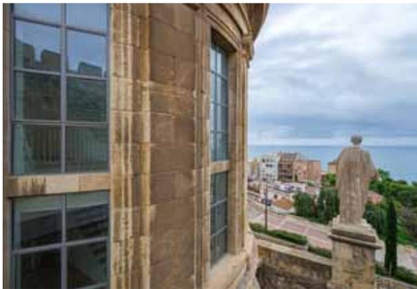
pic\_04 Die bauzeitlichen Konstruktionen wurden mit dem Stahlsprossensystem Janisol Arte 2.0 originalgetreu rekonstruiert.
