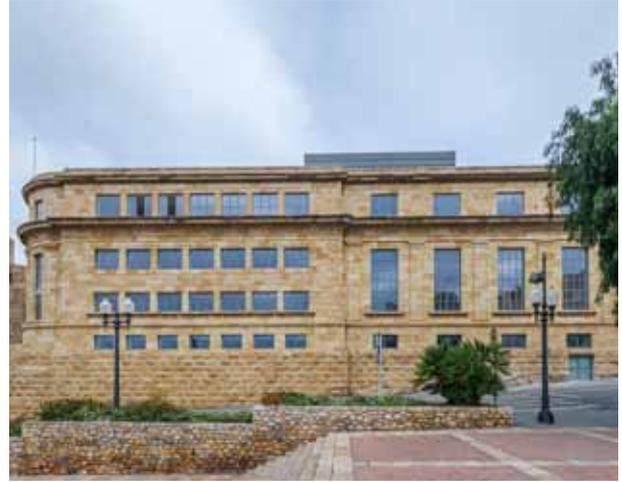
pic\_03 Die Klimatisierung wiederum bedingte die Erneuerung der verwitterten und undichten Stahlfenster aus T-Profilen und Einfachglas.
