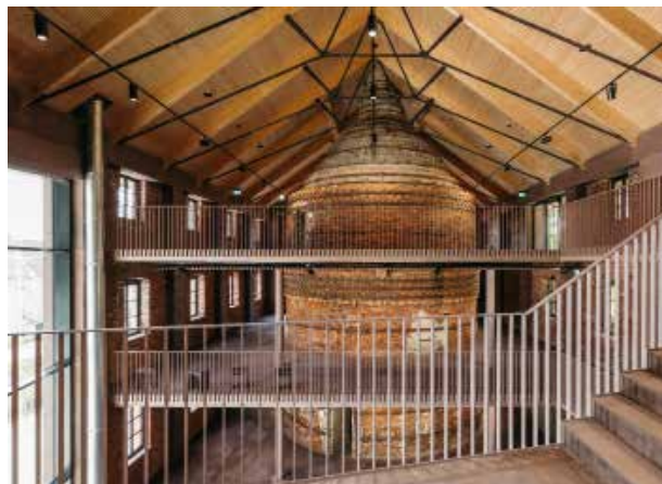
pic 02: Um den Rundofen herum wurden drei Geschossdecken als Galerien angeordnet, sodass man ihn „rundum“ betrachten kann.
