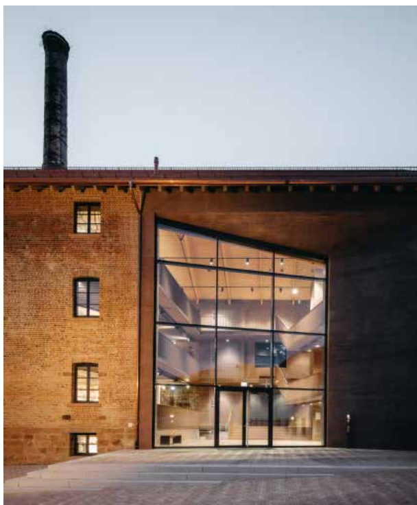
pic 01: Eine in ihrem höchsten Punkt 9,5 m hohe Glasfassade bildet das neue „Schaufenster“ zum historischen Rundofen.
