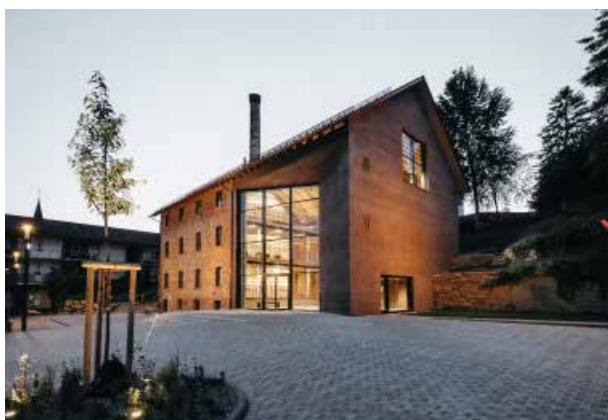
pic 03: Das Giebfenster (mit RWA-Lamellen) gibt den Ausblick in den Stadtpark frei; unten VISS Fassade mit Janisol Fenster.
