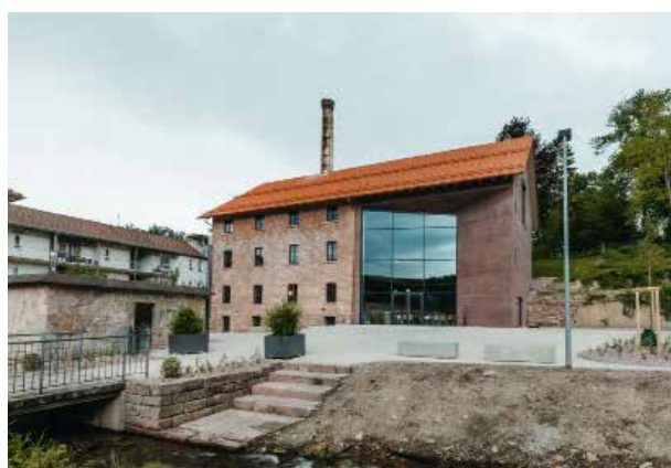
pic 05: Die aus dem Stahlsystem Janisol originalgetreu rekonstruierten Sprossenfenster bieten angemessenen Wärmeschutz.
