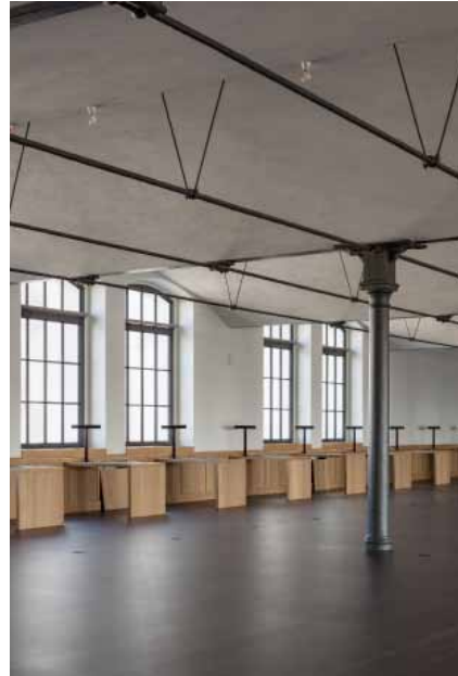
pic_05_AAC_6114_FotoTillSchuster: Zur Rekonstruktion wurden Stahlsprossen aus einem T-Profil (20 x 20 x 3 mm) in einen Rahmen aus Janisol Primo geschweißt.
