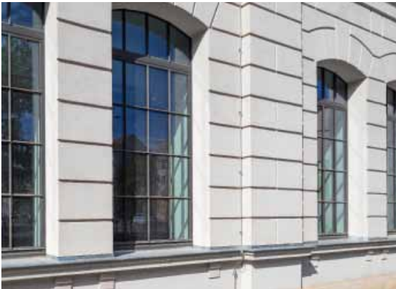
pic_03_AAC_7983_FotoTillSchuster: Die Festverglasungen wurden mit einer für diese frühe industrielle Phase typischen Fensterteilung und offenbarem Oberlicht rekonstruiert.
