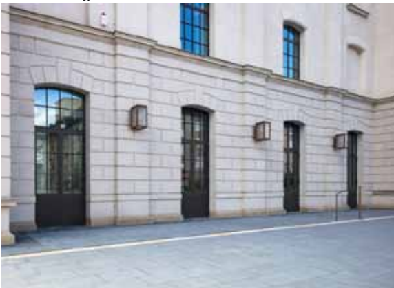
pic_04_AAC_7982_FotoTillSchuster: Die Außentüren an den Giebelseiten der Anbauten sind als übergroße Stichbogentüren aus dem Stahlprofilssystem Janisol Primo gefertigt.
