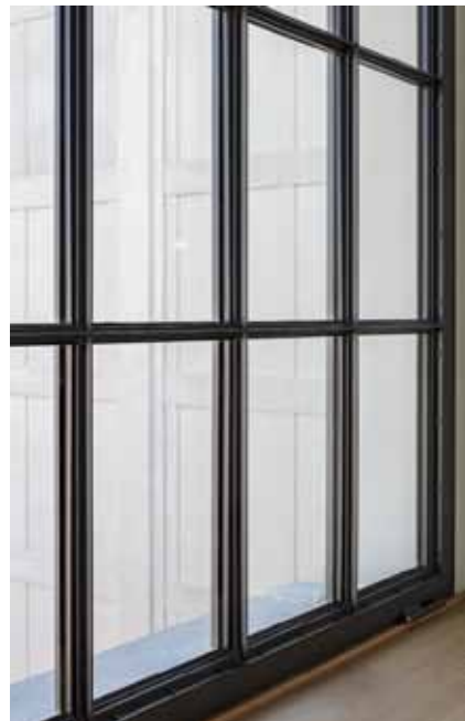
pic_06_AAC_6016_FotoTillSchuster: Schwarze Kunststoffsprossen im SZR vermitteln die Optik von glasteilenden Sprossen.
