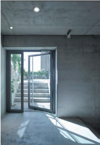
pic\_08: Die Türe zwischen Hof und Foyer ist mit einem Panikschloss mit Fallenfeststellung ausgestattet; diese Besonderheit wurde wegen der regelmässigen Hoffeste gewählt.
