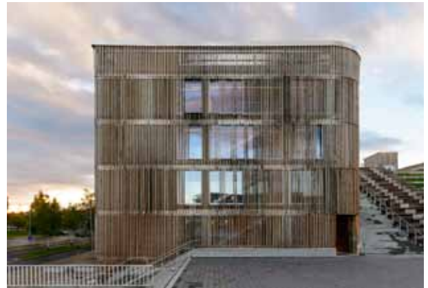
pic_5_FMO160915_1357.jpg: In den Erschliessungsbereichen ist die Fassade als Lochfassade mit vorgehängter Lamellenstruktur ausgeführt, und die innenliegenden Trennwände zu den Parkflächen sind verglast.
