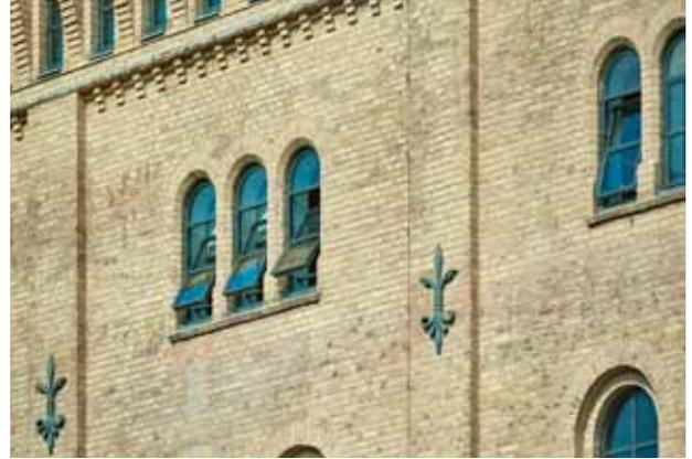
pic\_09\_B Schultheiss\_DSC3649.tif: Die Schwingflügel sind mit Öffnungssicherungen versehen, die ein Überschlagen verhindern; innenseitig ist die Absturzsicherung zu erkennen.
