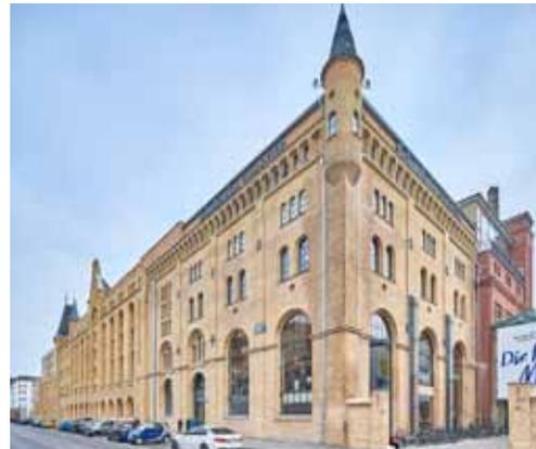
pic\_07\_B Schultheiss\_P0002735.tif: Über 450 Elemente, vom kleinen Drehflügel bis hin zur 8 m hohen Bogenkonstruktion, fertigte Jens Schröter Metallbau GmbH aus Baruth für das Projekt.
