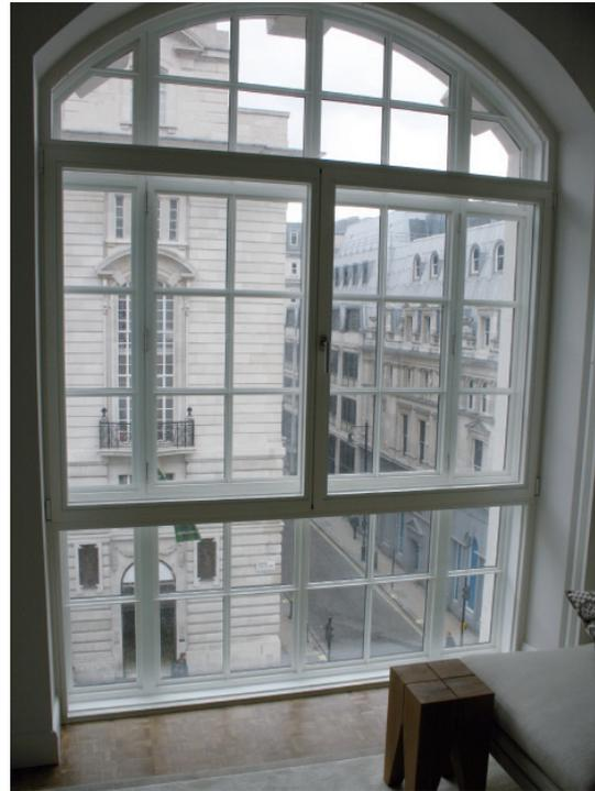
pic\_02: Die Architekten entschieden sich für die stilgerechte Erneuerung der grossen Fensterflächen mit einem Stahlprofilsystem.
