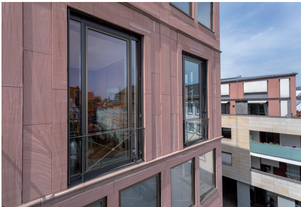
F4A0769x: Hinter den Geländern ist eine absturzsichernde Verglasung angebracht; textile Sonnenschutzrollos fahren bei Bedarf aus.
