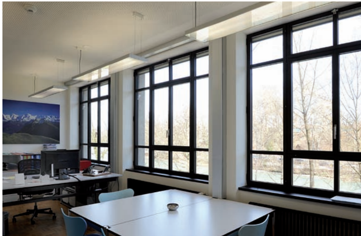
pic_04_PW_Schoenau_5193.tif: Die neue Befensterung mit Janisol Arte bietet zeitgemässen Wärmeschutz ...
