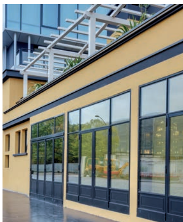
pic_12_molitor: Fenstertüren und Festverglasungen aus dem Stahlprofilsystem Janisol an der Südfassade; darüber die rekonstruierte Pergola.
