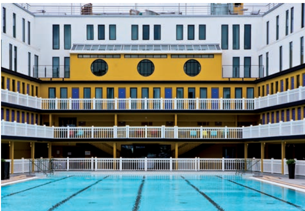
pic_06_molitor: Sicher: Fenstertüren und Festverglasungen der Hotelzimmer aus Janisol 2 bieten Brandschutz gemäss EI30. (Foto: Christophe Dugied)
