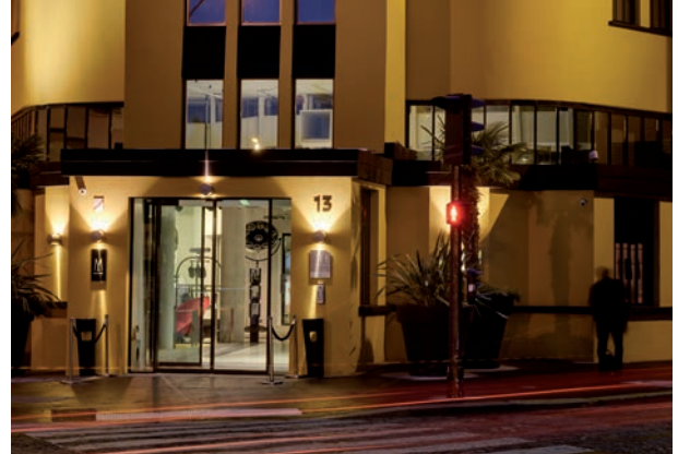
pic_03_molitor: Dezent: Die erstmals aus dem Stahlprofilssystem Janisol Arte gefertigten automatischen Schiebetüren bieten un-aufdringlichen Komfort.
