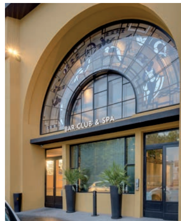
pic_13_molitor: Türen aus dem Stahlprofilsystem Janisol im Eingangsbereich des „Bar, Club & Spa“; darüber die originale Tiffany-Verglasung.
