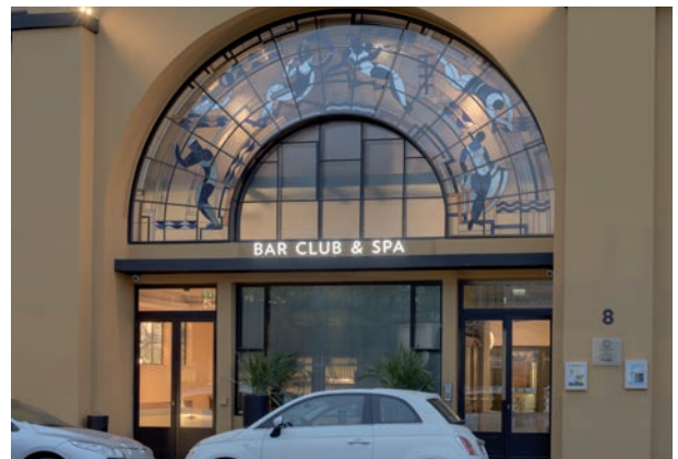
pic_05_molitor: Gekonnt: Eine feingliedrige Konstruktion aus dem Stahlprofilssystem Janisol Arte schützt die originale Tiffany-Verglasung.
