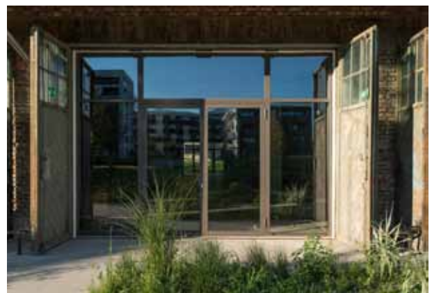
pic_07_panzerhalle_salzburg47.jpg: ... die 495 x 350 cm grossen Verglasungen der Toröffnungen an den Längsseiten, bestehend aus fest verglasten Teilen und zwei öffnbaren Flügeln.
