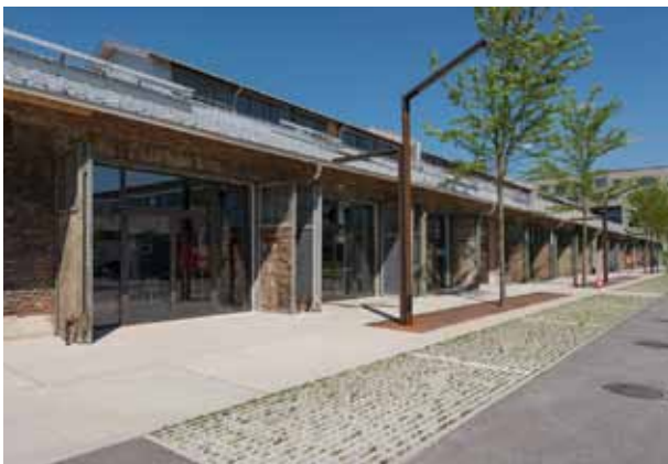
pic_04_panzerhalle_salzburg23.jpg: Das Backsteinmauerwerk blieb grösstenteils erhalten und auch die Originaltore wurden wieder eingehängt. Im Süden sind einige Parkplätze angeordnet, ...
