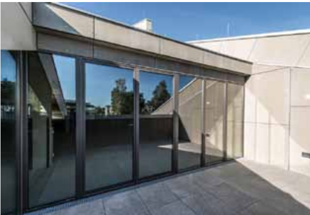
pic_10_panzerhalle_salzburg65.jpg: Auch die Verglasungen der neu geschaffenen Dachterrassen wurden mit Janisol HI ausgebildet.
