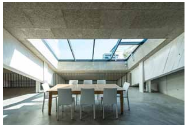
pic_13_panzerhalle_salzburg83.jpg: Zusätzlich eingezogene Betondecken schaffen mehr Fläche. Grosszügige Schrägverglasungen aus Jansen VISS TVS lassen viel Licht einfallen.
