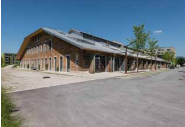
pic_02_panzerhalle_salzburg21.jpg: Die 200 m lange und 16 m hohe Panzerhalle wurde für die Sanierung in die Bauteile B, C und D gegliedert. Im Hintergrund Bauteil A, der Büroturm.
