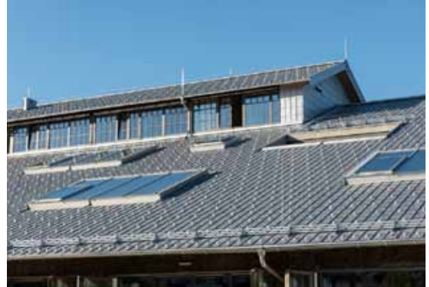
pic_03_panzerhalle_salzburg57.jpg: Dachfenster, -terrassen und -einschnitte für die Atrien durchbrechen die zuvor geschlossene Dachfläche. Die Laterne wurde originalgetreu wiederaufgebaut.
