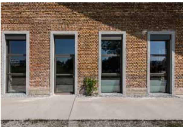
pic_06_panzerhalle_salzburg19.jpg: Die 120 x 320 cm hohen Öffnungen an den Giebelseiten wurden ebenso mit dem hoch wärmedämmenden Stahlprofilssystem Janisol HI ausgebildet wie ...
