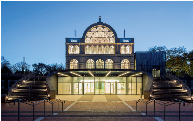
pic_02_jw1599-0001.jpg: Zu den wesentlichen räumlichen Veränderungen gehört die Ausbildung eines Sockelgeschosses. Hier ist unter anderem der neue Haupteingang angeordnet.
