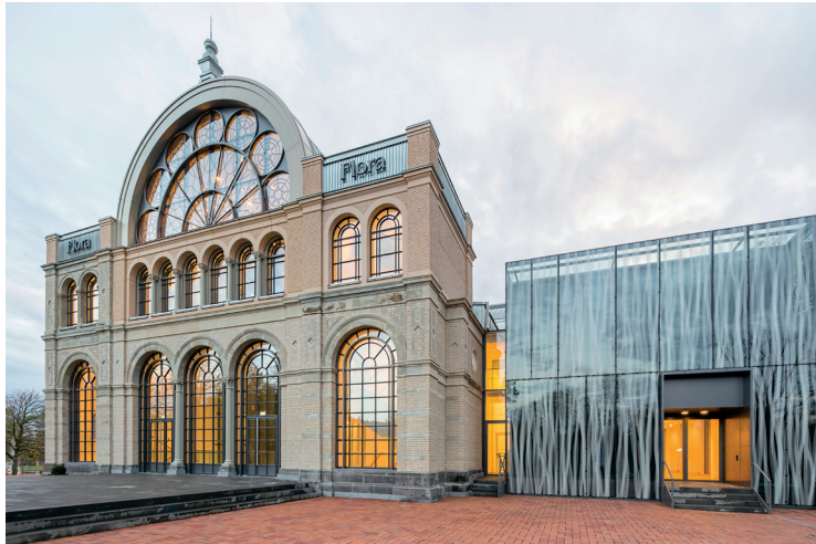
pic_03_jw1599-0004.jpg: Ein verglaster Neubau, der mit einer Glasfuge vom Bestandsbau abgelöst ist, ersetzt die heterogenen Anbauten aus der Nachkriegszeit.
