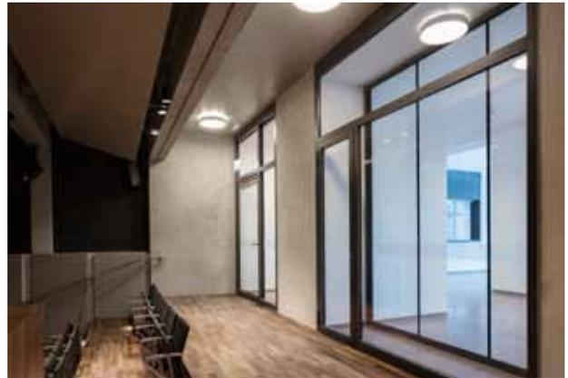
pic\_05\_phelps\_8410.jpg: Der Orchestersaal ist vom Foyer aus über zwei verglaste Türanlagen erreichbar. Foyerseitig sind die Türen als Brandschutztür ausgebildet, orchesterseitig als Rauchschutztür.
