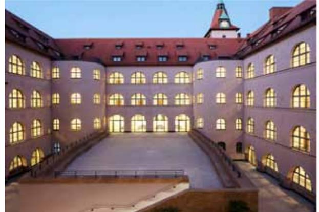
pic\_03\_phelps\_1810.jpg: Der Orchestersaal wurde in den Innenhof „eingeschoben“; sein begehbare Dach schliesst stufenlos an das Niveau des Erdgeschosses an.
