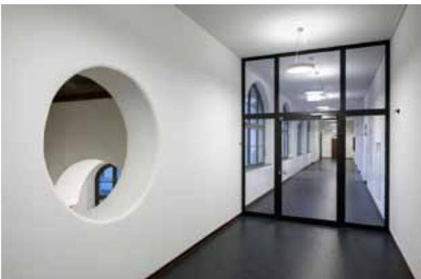
pic\_06\_phelps\_8480.jpg: Auch das Brandschutzkonzept musste der neuen Nutzung angepasst werden. Die umlaufenden Flure der vier Gebäudeflügel wurden in Brandschutzabschnitte unterteilt und mit verglasten Brand- und Rauchschutztüren geschlossen.
