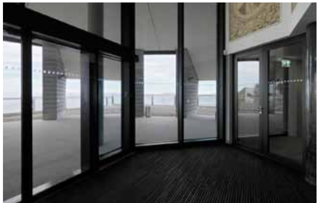
pic_05_efb_6572208.jpg: Verglaste Brandschutzabschlüsse aus Jansen VISS Fire, 50 mm, trennen die beiden Treppenhäuser vom Foyer. Rechts im Bild die Brandschutztür zum Besucheraufgang (Janisol 2 EI30).
