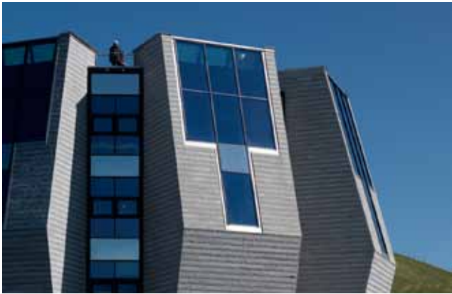
pic_02_efb_6571723.jpg: Panoramaverglasungen aus Jansen VISS HI TVS, 60 mm. Vertikale Fensterbänder aus VISS HI TVS, 50 mm, mit Öffnungsflügeln Schüco AWS 75 SI+ und Edelstahl-Füllelementen im Anschlussbereich der Decken.
