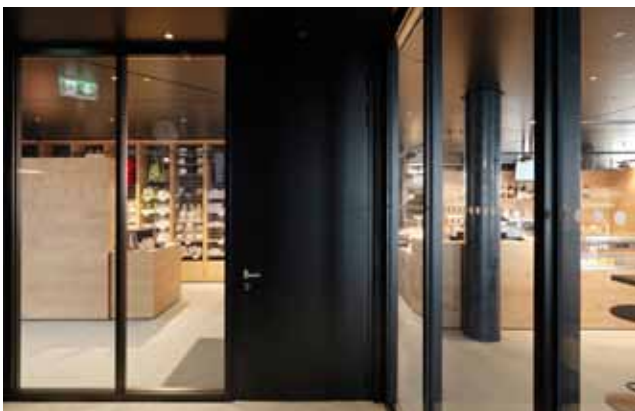
pic_07_efb_6572107.jpg: Die festverglasten Trennwände zum Selbstbedienungsbereich (pic_07) und zum Panoramarestaurant (pic_08) sind mit Jansen VISS Fire, 50 mm, in der Brandschutzanforderung EI60 gestaltet.
