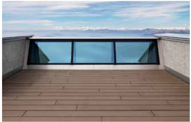
pic_03_efb_6572189.jpg: Der obere Bereich der Panoramaverglasung zieht sich bis auf Brüstungshöhe der Dachterrasse. Als innere Brüstung wurde eine zweite Verglasung aus dem gleichen Profilsystem V-förmig dagegensetzt.
