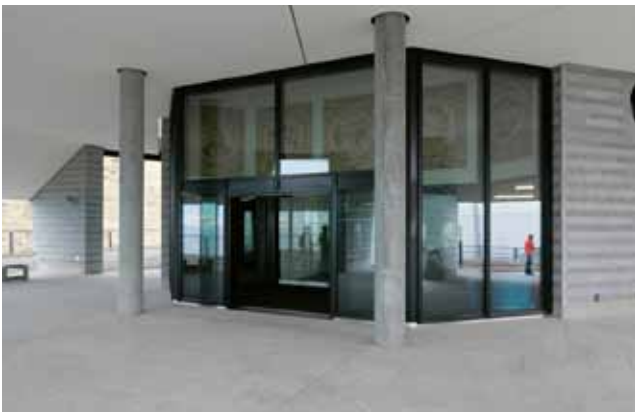
pic_04_efb_6572233.jpg: Auf dem Niveau des Bahnsteigs gelangen Besucher durch eine verglaste Schiebetür in das Foyer mit 4,5 m hohen Festverglasungen aus Jansen VISS HI, 60 mm.
