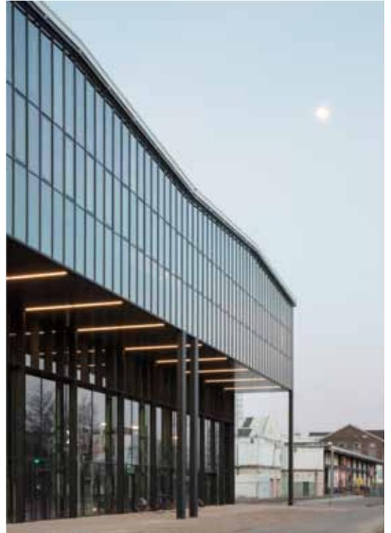
pic\_04\_LocHal\_CI-BIB4-2728.jpg: Für die neuen Fassaden wählten die Architekten das Stahlprofilssystem Jansen VISS.
