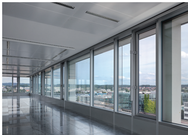
pic_07_lux.tif: Selbstverständlich ist die raumhohe Verglasung absturzsicher ausgeführt. Darüber hinaus bietet sie erhöhten Schallschutz.
