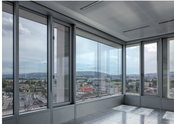
pic_05_lux.tif: Die Verglasung lässt viel Tageslicht einfallen. Einzelne Fens-terelemente können zum Lüften geöffnet werden.
