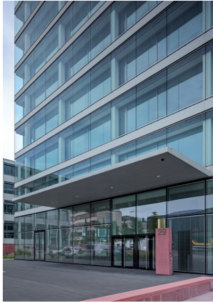
pic_02_lux.tif: Die Pfosten-Riegel-konstruktion im Erdgeschoss ...
