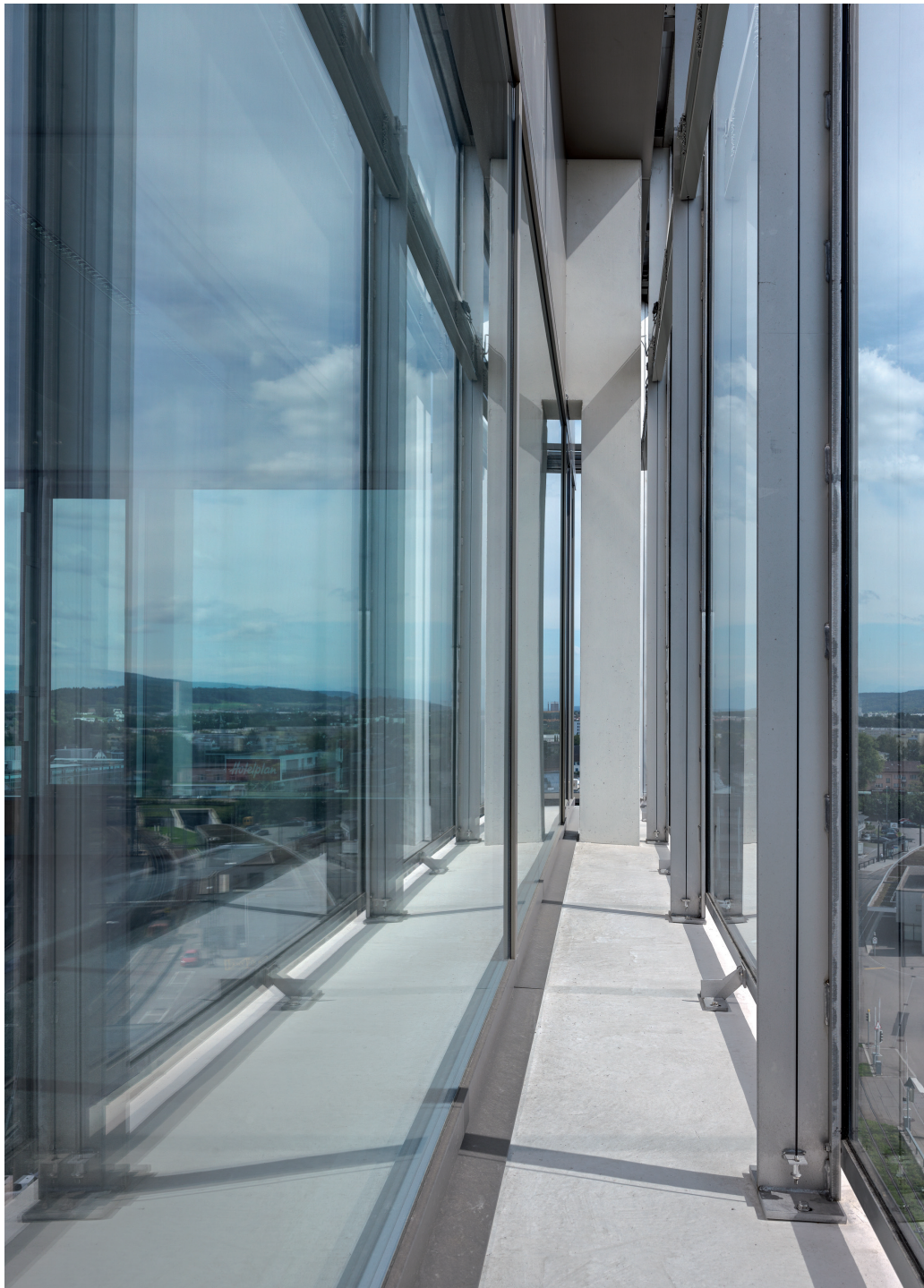
pic_01_lux.tif: Die Fassadenkonstruktion des LUX Building erfüllt die Richtlinien des Minergie-Standards.
