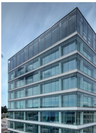
pic_06_lux.tif: Die vollverglaste Fassa-de ist Baustein des Energiekonzepts.
