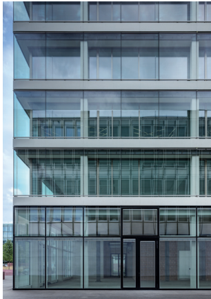
pic_04_lux.tif: Gut sichtbar: Stimbündige Vorverglasung aus VSG.
