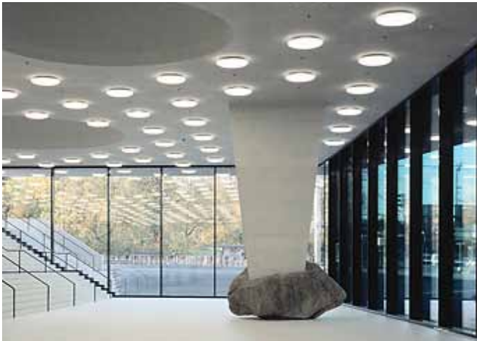
pic_01_171108_002_w.jpg: Grundstein der Hallenerweiterung ist ein 25 t schwerer Findling aus dem Gotthardmassiv. Die ihm entwachsende Säule trägt das Technikgeschoss, welches das Vordach bildet.
