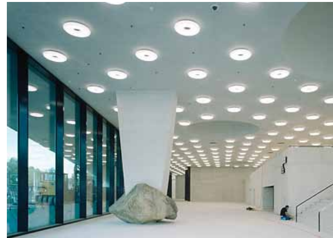
pic_02_171004_001_w.jpg: Nur 60 x 280 mm messen die Pfosten der freitragenden Pfosten-Riegel-Konstruktion Jansen VISS Fassade; sie wurden in ihren unteren Endpunkten mit angeschweissten Fussplatten zusätzlich verstärkt.
