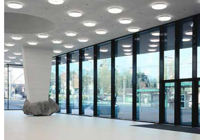
pic_04_171108_003_w.jpg: Die in die Glasfassade eingebundenen Eingangstüren fertigte der Metallbauer aus dem Stahlprofilssystem Janisol HI. Die nahezu drei Meter hohen Konstruktionen wurden ein- und zweiflügelig, nach aussen öffnend, verbaut.
