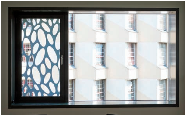
pic_05: Bei den festverglasten Elementen aus Jansen VISS RC3 (nach DIN EN 1627) mit Öffnungsflügel Janisol Primo bilden das Stahlprofilsystem und das Lochpaneel aus Hartmanganstahlblech eine konstruktive Einheit.
