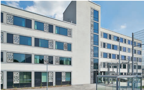
pic_02: Der langgestreckte Zeilenbau reduziert sich von fünf auf vier Geschosse. In der Mittelzone sind die Räume der AVD-Mitarbeiter sowie die Erschliessung mit Aufzügen und Treppenhaus angeordnet.
