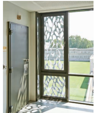
pic_04: ... und analoger Gestaltung in den Geschossen darüber. Hier entspricht die Konstruktion den TRAV.
