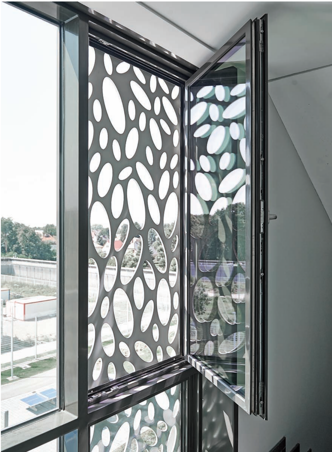
pic_01: Das zweiteilige Standardfenster ist eine konstruktive Einheit bestehend aus einem grossformatigen, mit transparentem Spezial-sicherheitsglas fest verglastem Element, einem verglasten, öffenbaren Lüftungsflügel sowie einem vor den Lüftungsflügel eingespannten, ausbruchsicheren Schmuckelement aus Hartmanganstahllochblech.
