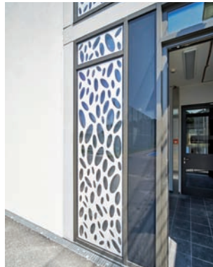
pic_03: Eingangsbereich in der Mittelzone mit eingespanntem Schmuckelement ...
