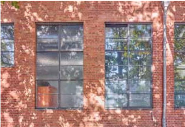
pic\_04 CF018111.tif: Südfassade; Strassenseite „Am Juliusturm“, Mitteltrakt: Die Abbildung zeigt links ein historisches Fenster, das aufgearbeitet wurde, neben einem rekonstruierten Fenster (rechts). Auf den ersten Blick ist kein Unterschied zu sehen.
