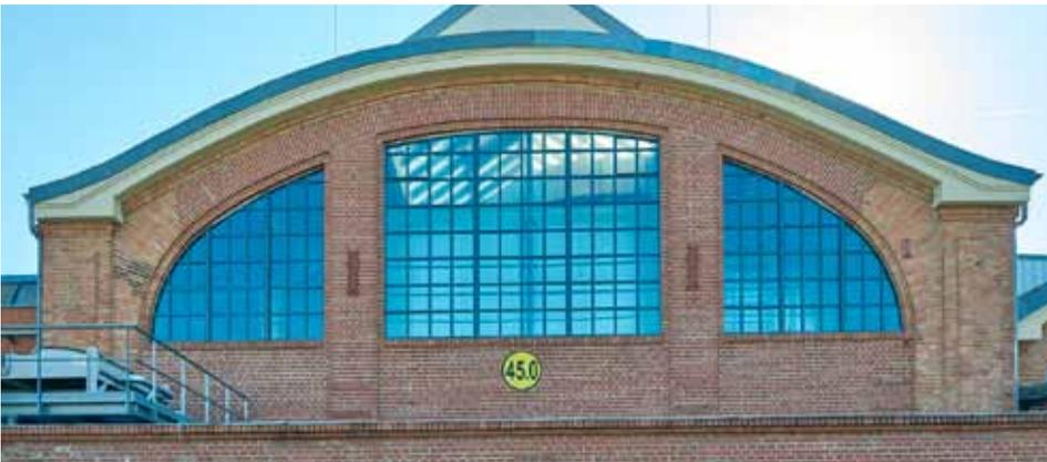
pic\_06 DSC1945.tif: Nordfassade; Gebäude Nr. 45: Die Rundbogenfenster im Giebel sind teils bis zu 4 m hoch. In diesen Bereichen wurden als Unterkonstruktion senkrechte Schwerter in die Fensteröffnung eingebaut, um die Lasten der Zweifachisolierverglasung in den wärmedämmenden Profilen sowie der nicht unwesentlichen Belastung aus Winddruck und -sog abzufangen.
