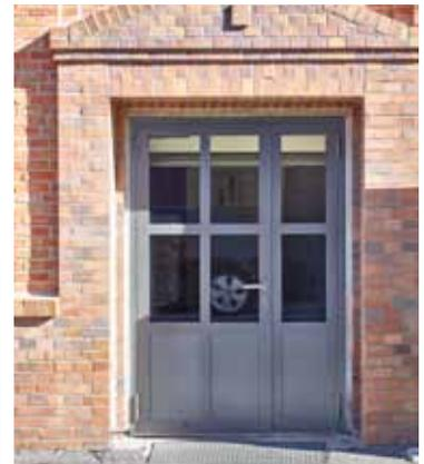
pic\_07 CF013441.tif: Westfassade: Nach aussen zu öffnende Treppentür mit seitlichem Feststellflügel aus Janisol.
