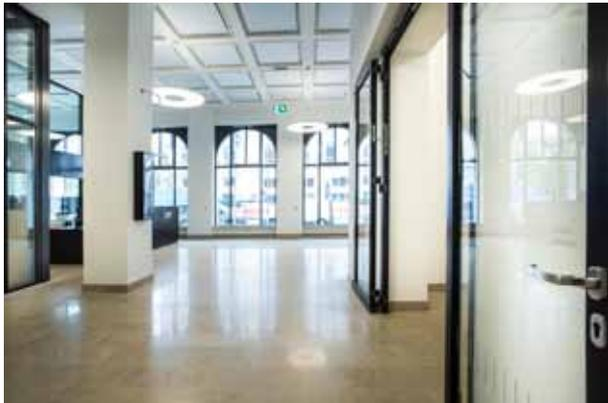
pic\_05\_023\_IHK\_Stammhaus\_innen.jpg: Die Rundbogenfenster wurden mit dem Stahlprofilssystem Janisol originalgetreu rekonstruiert; jedoch mit erhöhten Sicherheitsanforderungen (RC2) gefertigt. Rechts: absolut plan öffnende Janisol 2-Brandschutztüre.
