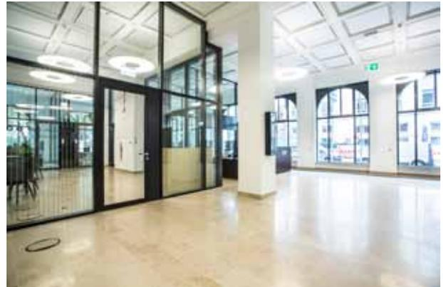
pic\_04\_022\_IHK\_Stammhaus\_innen.jpg: Innenwände aus dem Fassadenprofilsystem VISS Fire, teils mit Schallschutzfunktion und in den Paneelen integrierten Lichtschaltern.
