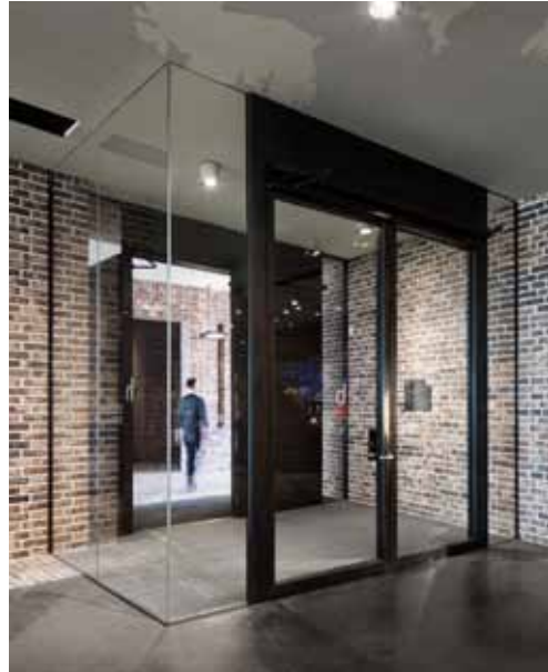
pic_03: Über den verglasten Windfang, der sich in das Foyer schiebt, werden die Materialien der Außenfassade nach innen geführt. Die Stahlprofile der Türkonstruktion (Jansen-Economy 60) sind ebenfalls mit feinen Blechen aus Baubronze vollflächig bekleidet.
