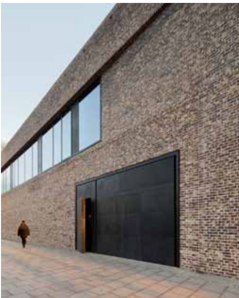
pic_04: Die Einbringungsöffnung (Janisol HI, vollverblecht) mit Schlupftür auf Strassenniveau fügt sich flächenbündig in das Ziegelmauerwerk ein. Darüber befindet sich ein Lichtband (VISS Linea), welches das Foyer im ersten OG belichtet. In Analogie zu den Türen sind die Fensterflügel (Janisol HI) vollverblecht.
