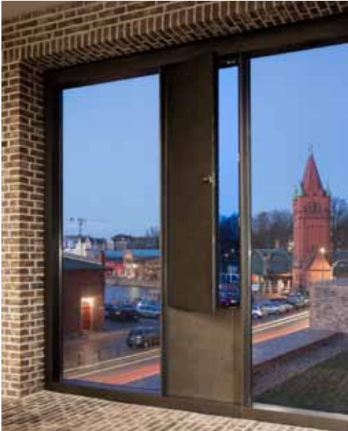
pic_06: Vollverblechte Öffnungsflügel (Janisol HI) gliedern die Festverglasung im Foyer. Diese überraschende Interpretation von „Fenster“ lässt Blend- und Flügelrahmen zu einer optischen Einheit verschmelzen, wodurch die Konstruktion insgesamt schmäler wirkt. (siehe Systemschnitt 2)
