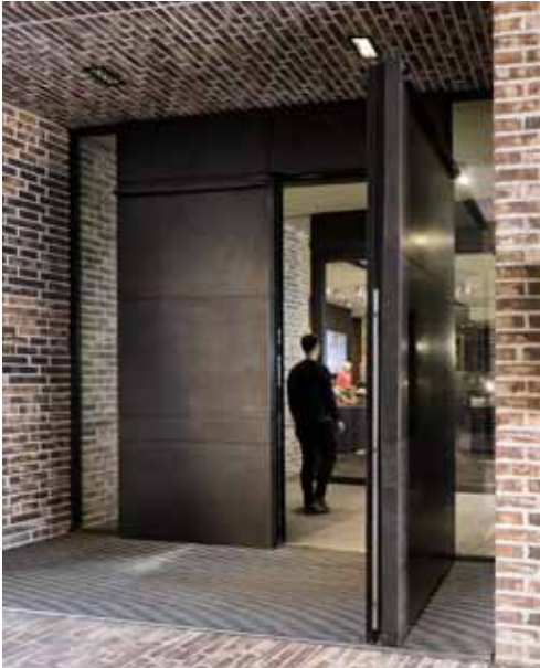
pic_02: Besucher erreichen den Haupteingang des Neubaus über die zentrale Treppenanlage, die den historischen Hafen mit der höher gelegenen Altstadt verbindet. Die vollverblechten Drehtüren (Janisol HI) sind mit Paneelen aus fein geschliffener und gravierter Baubronze behangen. (siehe Systemschnitt 1)
