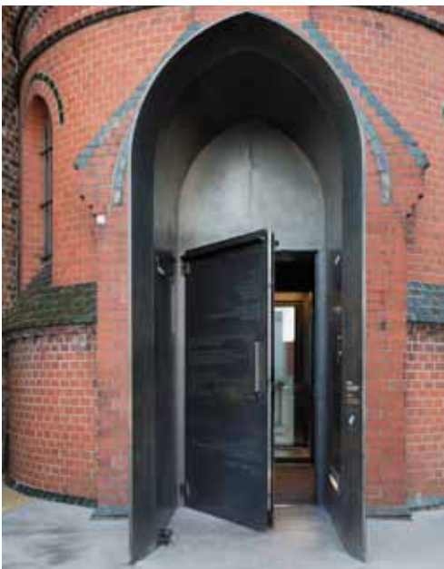
pic_08: Das denkmalgeschützte Burgkloster erhält einen neuen Eingang. Der Spitzbogenvorbau ist ebenso wie die flächenbündig eingebrachte Automatiktür (Janisol) mit Baubronze verkleidet.
