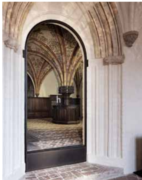
pic_09: Die Festverglasung gestattet einen Blick auf die öffentlich nicht zugängliche Sakristei. Das mit Baubronze vollflächig verklebte Stahlprofilssystem (Jansen-Economy 60) folgt exakt der Rundung der Laibung – einschliesslich der Aussparung im oberen Bereich.
