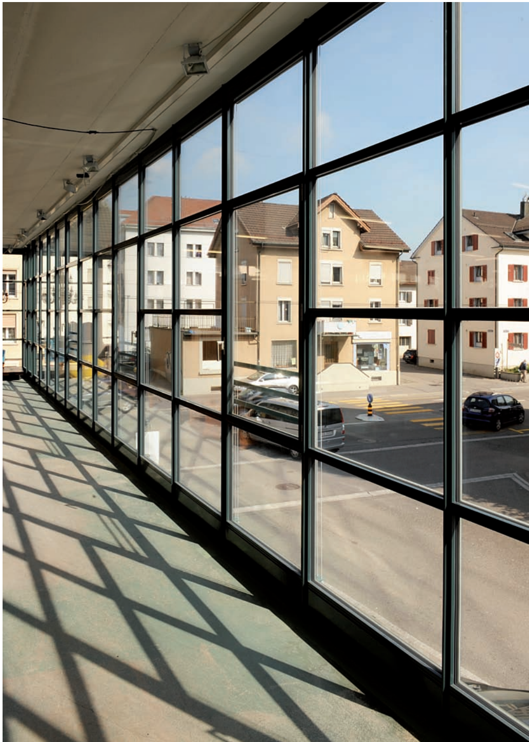
pic_01_GHZuercherstr_5307_20cm.tif: Mit Janisol Arte war es möglich, die feingliedrige Glasfassade aus den 1960er-Jahren wiederherzustellen.
