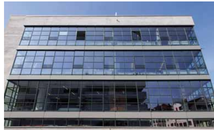
pic_05_GHZuercherstr_5313_20cm.tif: Die sanierte Fassade ist dreifach verglast, um die Mietflächen vor dem Verkehrslärm der viel befahrenen Zürcher Strasse zu schützen.
