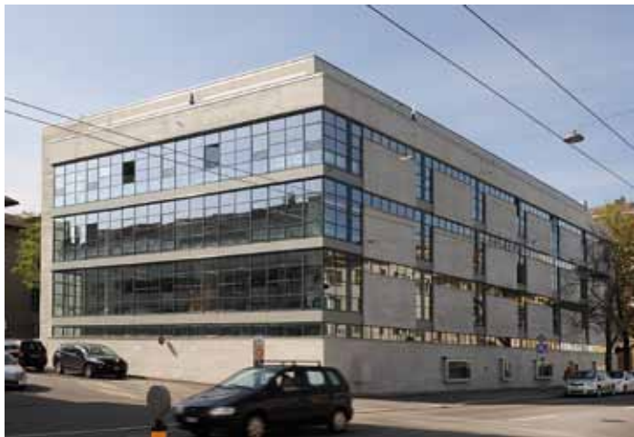
pic_03_GHZuercherstr_5291_20cm.tif: Der Wechsel von freistehenden Betonwänden mit Fensterbändern lockert die Fassadenansicht auf.
