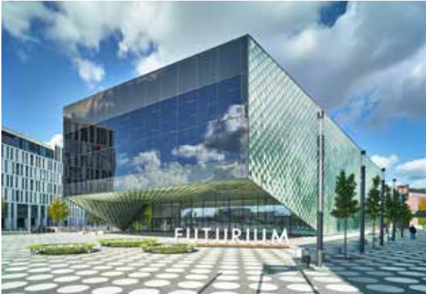
pic_03.tiff: Das Futurium versteht sich als Museum, Labor und Forum für die Diskussion von Zukunftsfragen. Auch beim Gebäude selbst haben die Architekten mit vielen Sonderkonstruktionen die Grenzen des heute Machbaren ausgelotet.
