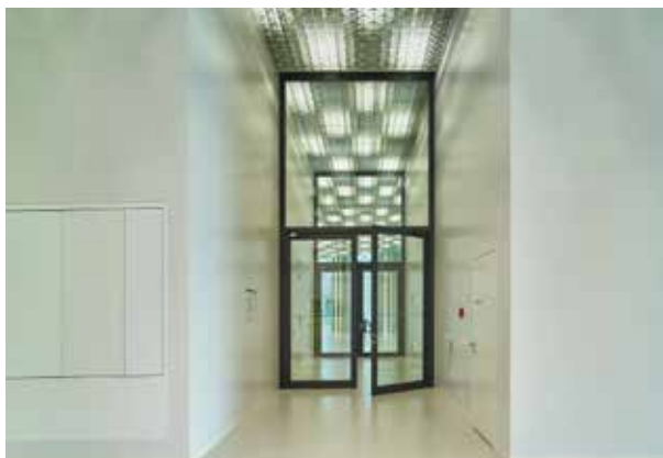
pic_07.tiff: Die Zugänge vom Foyer zum Veranstaltungsforum sind als zweiflügelige Türelemente mit erhöhten Schallschutzanforderungen ausgeführt. Das schlanke Türprofil hält eine Oberlichtverglasung von ca. 3000 x 3000 mm.
