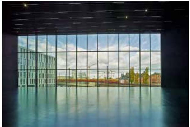
pic_06.tiff: Die in die hängende Pfosten-Riegelkonstruktion aus VISS SG eingesetzten Dreifach-Isolierverglasungen sind circa 2,3 x 4 m gross und als Structural-Glazing-System ohne sichtbare Glashalter befestigt.
