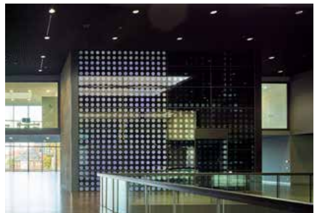
pic_08.tiff: Mit Paraffin gefüllte und farbigem Licht bespielte Scheiben verkleiden den Aufzugskern und einen Paraffinspeicher, der Solarenergie speichert. Auch diese Einhausung wurde mit dem Structural-Glazing-System VISS SG konstruiert.
