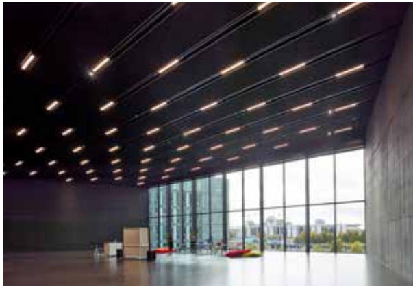
pic_05.tiff: Die zwei Felder hohe Südfassade (pic_05) und die drei Felder hohe Nordfassade (pic_06) hängen an fünf bzw. sechs Zuglamellen aus Stahl, die von einem oberen Stahlkasten-hohlträger abgehängt sind.
