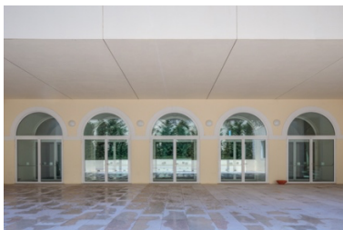
Bilder 5,6,7: Das Brandschutzsystem Janisol 2 erfüllt in Form der Rundbogenfenster im historischen Stil wie kein anderes System die Ansprüche in Bezug auf bauliche Sicherheit und gestalterische Freiheit. Es ist ausgesprochen filigran und trotzdem sehr stabil.
