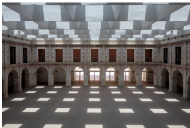
Bild 1: Nach der Sanierung bieten der imposante Charakter, das Licht und die Materialität des Convento do Beato einen idealen und sicheren Rahmen sowie Raum für bis zu 5500 Personen.
