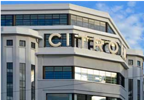
pic_04_citroen.jpg: In den Fensterbändern wechseln satinierte mit klaren Gläsern. Früher befanden sich die satinierten Scheiben in den unteren Reihen und fungierten als Sichtschutz; heute sind sie oben angebracht und erhöhen den Sonnenschutz. (Foto: Descasystem)
