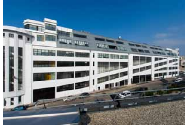
pic_03_citroen.jpg: Die innenliegenden Rampen sind an der Fassade zur Rue Béchevelin hin klar ablesbar. Die kleinteiligen Fenster und Festverglasungen wurden mit Janisol Arte originalgetreu rekonstruiert. (Foto: Guillaume Perret)
