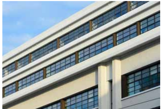
pic_05_citroen.jpg: Die restaurierten Rampen erschliessen die rund 170 Stellplätze auf den oberen Stockwerken. So gelangen motorisierte Nutzer bis vor die Eingangstüre ihres Büros. (Foto: Descasystem)
