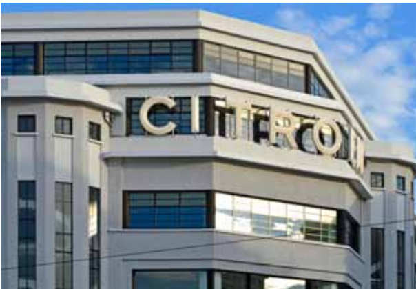
pic_04_citroen.jpg Dans les fenêtres en longueur, les vitres satinées alternent avec les vitres transparentes. Auparavant, les vitres satinées étaient situés dans les rangées inférieures et servaient de pare-vue; aujourd'hui, elles sont positionnées en haut et renforcent la protection solaire. (photo: Descasystem)
