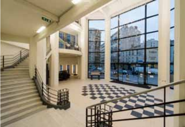
pic_02_citroen.jpg: A l'intersection de deux axes routiers très fréquentés, le hall d'entrée restauré, avec son vitrage fixe de 18 m de haut, réserve aux nouveaux usagers un accueil au style soigné. (photo: Guillaume Perret)
