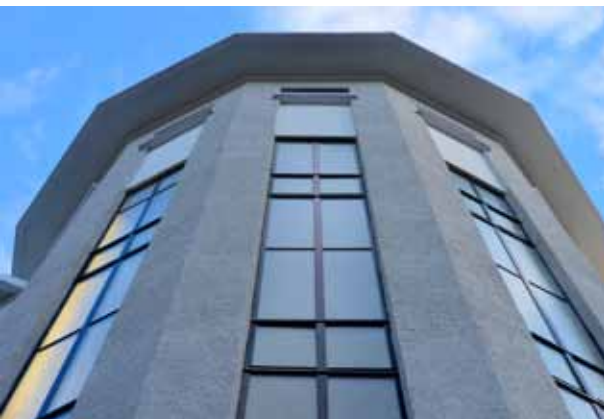
pic_06_citroen.jpg: L'accès à pied s'effectue via cinq montées d'escalier situées dans les tours d'angle. Des vantaux de fenêtre réalisés avec le système de profilé en acier Janisol Arte ont été intégrés dans les profils restaurés des vitrages fixes. (photo: Descasystem)
