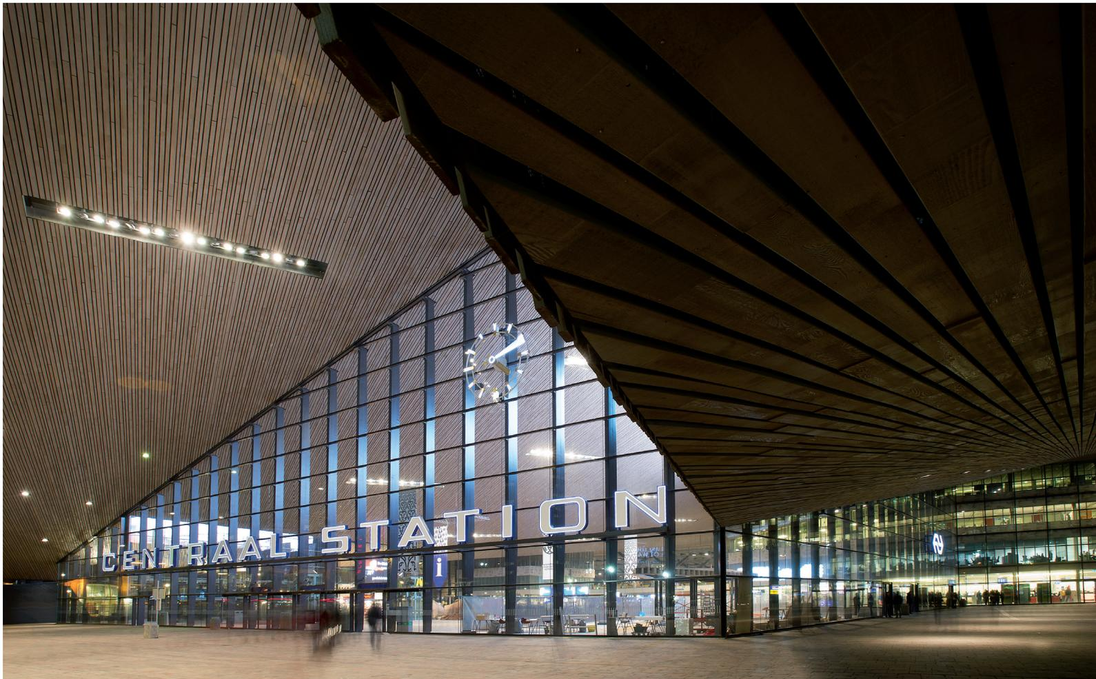
pic\_01.tif: An ihrem höchsten Punkt ist die Fassade 20,50 Meter hoch. Die Stahl-Leichtkonstruktion muss enormen Windlasten standhalten.
