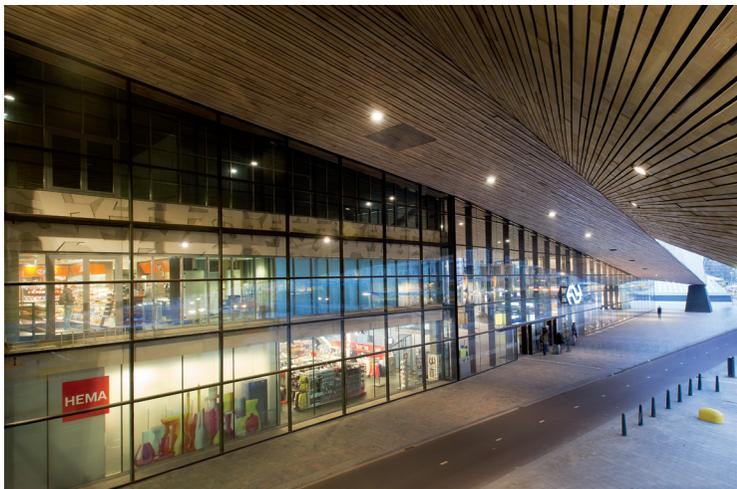
pic\_04.tif: Horizontale Riegel aus dem Stahlprofilssystem VISS Basic tragen die bis zu 700 kg schweren VSG-Scheiben.
