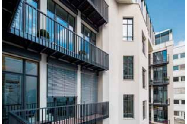
pic_05: Die Büroräume zur Hofseite hin haben die Architekten mit raumhohen Verglasungen versehen und Balkone vorgelagert. So ist ein lichtdurchflutetes Ambiente entstanden, das heutige Anforderungen an ein zeitgemässes Arbeitsumfeld erfüllt.
