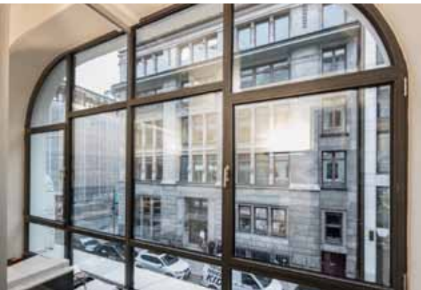
pic_06: Die grossformatigen Stahlfenster – mit geradem oder gebogenem oberem Abschluss – und auch das 6,30 m breite Eingangsportal (siehe pic 2) wurden in der Werkstatt von L & F Metallbau GmbH, Stahnsdorf, gefertigt.
