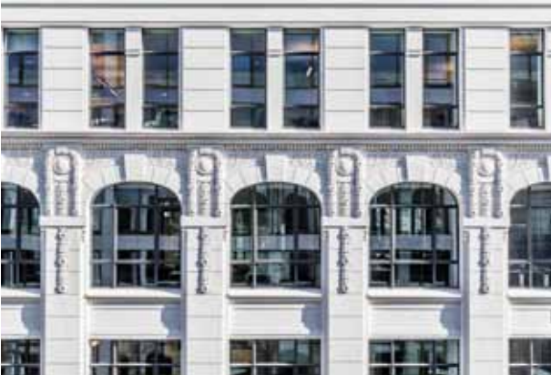
pic_04: Da eine historische Beschreibung des Gebäudes den Hinweis auf Stahlfenster enthielt, wurden sämtliche Fenster mit dem Stahlprofilssystem Janisol Arte 2.0 rekonstruiert. Die Architekten haben die Ansichtsbreite von aussen durch einen aufgesetzten Flachstahl weiter aufgelöst.
