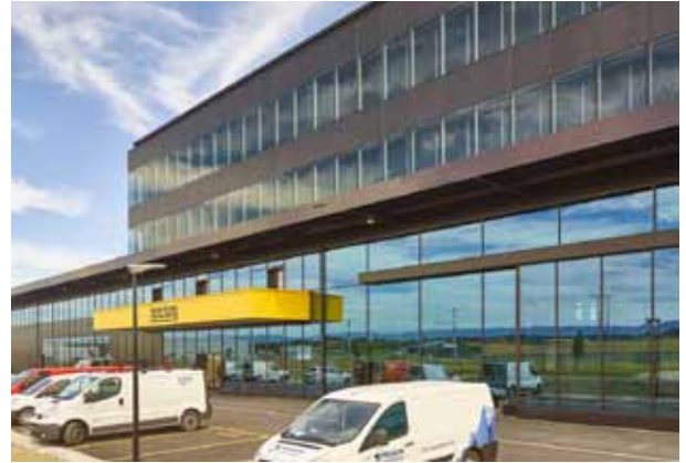
pic_03.jpg: Ein Vordach mit dem Logo des Herstellers signalisiert den Haupteingang. Links daneben eines der beiden grossformatigen Schiebetore, die als objektspezifische Sonderkonstruktion aus Jansen VISS gefertigt wurden. (© Foto: Jansen AG)
