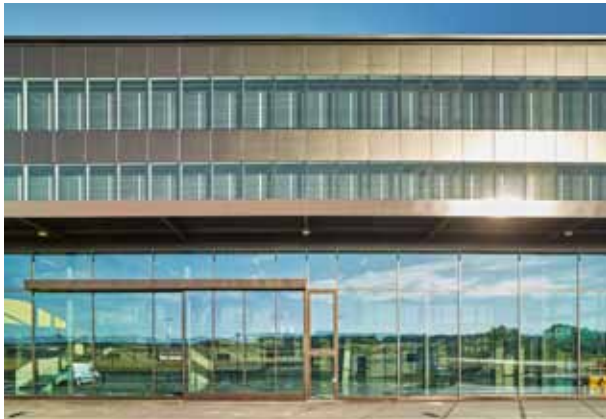
pic_04.jpg: Links neben dem 6 m hohen Schiebetor ist eine Fluchttüre als Vollpaniktür gemäss EN 1125 (Norm für Bereiche mit Publikumsverkehr) angeordnet. Sie wurde aus dem Schüco-Profilsystem ADS 75.SI gefertigt. (© Foto: Jansen AG)
