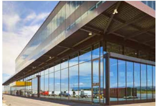
pic_05.jpg: Eine weitere Vollpaniktüre befindet sich im Eckbereich des Showrooms; über Eck schliesst das 10,5 m breite, 6 m hohe Schiebetor aus dem Stahlprofilssystem Jansen VISS 60 an. (© Foto: Jansen AG)
