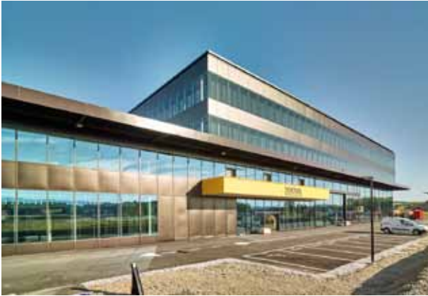
pic_02.jpg: Die 7,50 m hohe Glasfassade aus hochstatischen Stahlprofilen Jansen VISS 60 TV wird nahezu um das ganze Gebäude herumgeführt. Nur wenige Fassadenbereiche sind mit Faserzementplatten (Duripanel®) verkleidet. (© Foto: Jansen AG)
