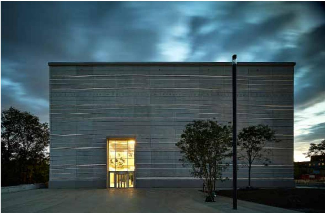
pic\_03\_BauhausMus\_P0004127: Horizontale Lichtbänder aus LEDs strukturieren die Fassade. Sie sind in Fugen des Sichtbetons verlegt und beginnen mit Einbruch der Dämmerung zu leuchten.
