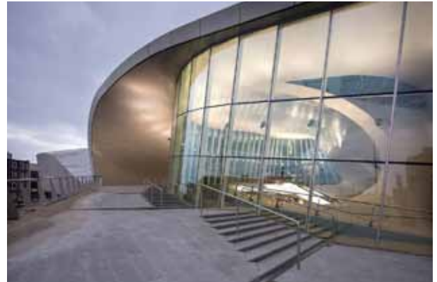
pic_05: Neben dem wärmedämmenden Stahlprofilssystem VISS Basic brachte Jansen die unternehmenseigene Entwicklungskompetenz in das Projekt mit ein.
