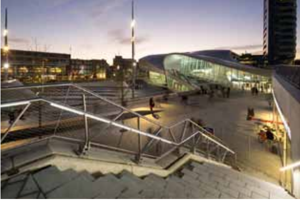
pic_02: Sichtbeton und Glas charakterisieren das neue Empfangsgebäude. Nicht nur die Fassade, auch das Dach ist in weiten Teilen verglast.
