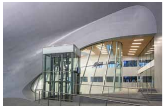
pic_07: Brandschutzkonstruktionen mit Jansen VISS Fire gewährleisten die von den Architekten angestrebte Transparenz auch im Inneren des Gebäudes.
