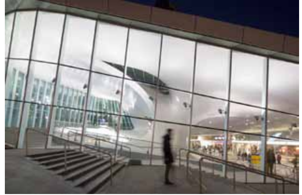
pic_03: Die Realisation der freitragenden Glasfassade erwies sich als anspruchsvolle Aufgabe, die eine enge Zusammenarbeit von Planer, Fassadenbauer und Profilversteller erforderte.
