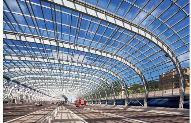
pic\_03\_Lichtdach.tif: Die Unterkonstruktion ist im regelmässigen Abstand von 6 Metern aufgebaut.
