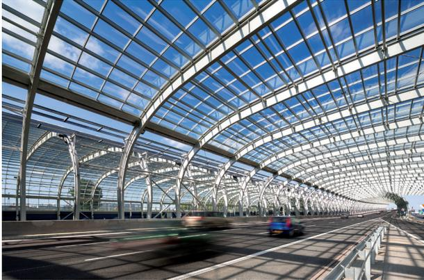
pic\_02\_Lichtdach.tif: Die gläserne Einhausung ist 1200 Meter lang; alle 200 Meter befindet sich ein Notausgang.
