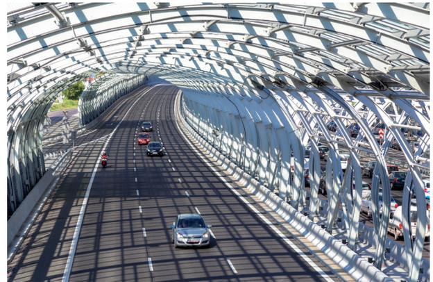
pic\_05\_Lichtdach.tif: Die grossflächige Vertikalfassade ist zulassungskonform und erfüllt die Lärmschutzanforderung  $R_w = 39$  dB.
