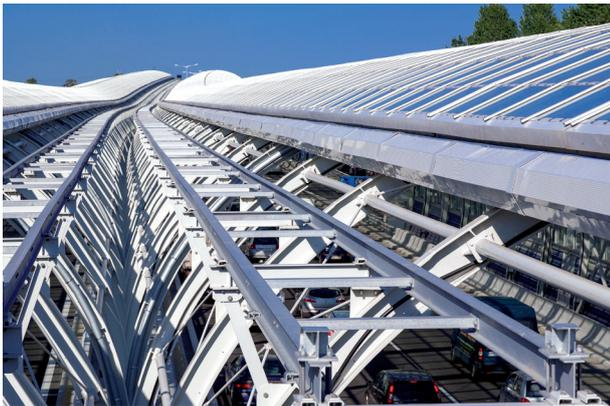
pic\_04\_Lichtdach.tif: Nach oben ist das Lichtdach teilweise offen: Ca. 15 % der Fläche sind nicht verglast.
