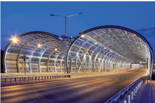
pic\_06\_Lichtdach.tif: Der Kreisdurchmesser der Tragkonstruktion variiert von 32 bis 64 Meter.
