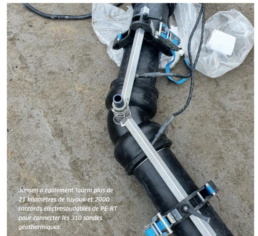
*Jansen a également fourni plus de 21 kilomètres de tuyaux et 2000 raccords électrosoudables de PE-RT pour connecter les 310 sondes géothermiques.*
