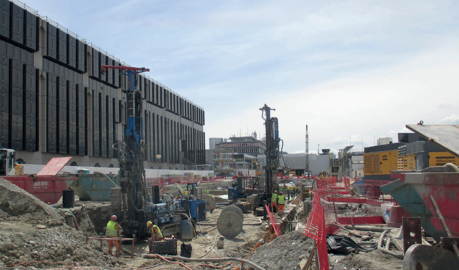
Deux des quatre ateliers de forage sur un chantier complexe à coordonner.
