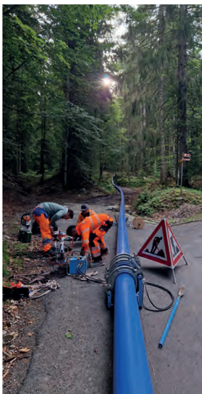
Vor der Verschweissung musste kein Schutzmantel entfernt werden; dies gewährleistet speditives Verarbeiten und Sicherheit beim Einzug.
