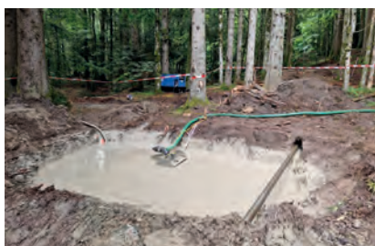
In der Zwischengrube wurde die Bentonit (Tonminerale) Spülung aufgefangen und mittels eines Lastwagens regelmässig zu einer mobilen Recycling-Anlage vor Ort transportiert. Somit konnten Kosten gesenkt und auch der ökologische Aspekt beachtet werden.
