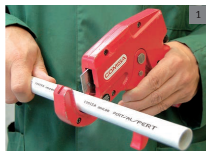
Rohr ablängen
