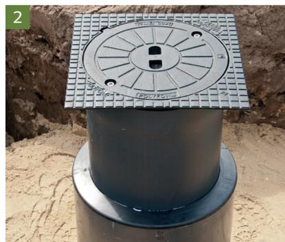
Durch das Teleskoprohr ist nun eine exakte Höhenanpassung entsprechend den Planungsvorgaben möglich. Hierbei ist auf eine mindesteinsteck tiefe des Teleskoprohres in der Teleskopmanschette von min. 100 mm zu achten. Der Schacht ist nun lagenweise (max. 30 cm) gemäss DIN EN 1610 weiter zu verfüllen und zu verdichten.
