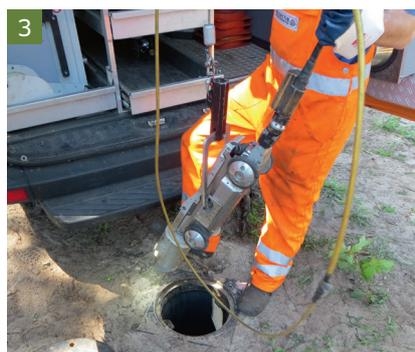
Zur Inspektion mittels TV-Befahrung ist die Sedimentationsanlage gemäss Schritt 2 zu entleeren und zu reinigen. Anschliessend wird mittels TV-Kamera die Anlage durch den Ablaufschacht inspiziert. Die Inspektion sollte in Richtung des Zulaufschachtes erfolgen. Im Rahmen der Inspektion sollten alle Einbauteile sowie die Innenwandung auf Ablagerungen und/oder Beschädigungen hin untersucht und begutachtet werden.
