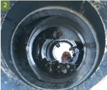
Für die Reinigung der im Dauerstau betriebenen Sedimentationsanlage wird angeraten, zunächst den Zulauf zu sperren. Des Weiteren ist zu überprüfen ob die Anlage beim Einbau im Grundwasser ohne Befüllung ausreichend gegen Auftrieb gesichert ist. Das Abpumpen des in der Anlage enthaltenen Regenwassers erfolgt in der Regel durch den Ablaufschacht.
