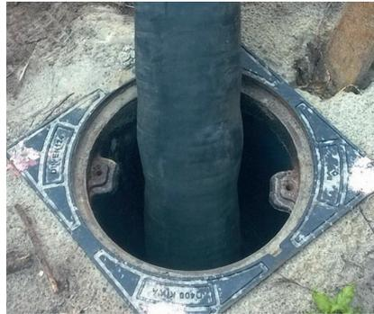
Zum Öffnen der Inspektionsschächte ist gemäss erster Kontrolle des Schlammfangs vorzugehen. Sollten Leichtflüssigkeiten auf der Wasseroberfläche der Anlage enthalten sein, sind diese vorab fachgerecht abzusaugen und zu entsorgen. Dieser Vorgang wird bis zur vollständigen Reinigung der Anlage durchgeführt. Durch den Ablaufschacht ist schliesslich das Regenwasser mittels Saugschlauch abzusaugen und fachgerecht zu entsorgen.
