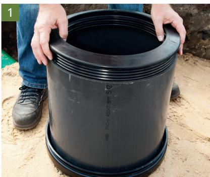
Das Schachtrohr ist je nach Einbautiefe ggf. zu kürzen, zu entgraten und die Teleskopmanschette ggf. zu reinigen. Die Manschette ist dann bis zum Anschlag in das Schachtrohr einzustecken. Hierbei ist kein Gleitmittel zu verwenden. Das angefastete Teleskoprohr der Teleskopabdeckung ist dann gleichmässig mit Gleitmittel zu versehen und in die Manschette einzuführen.
