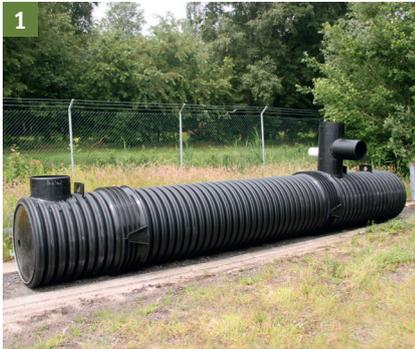
1 Vor dem Einbau sind alle Bauteile auf Vollständigkeit, eventuelle Beschädigungen oder Verunreinigungen zu prüfen. Beschädigte Bauteile dürfen nicht eingebaut werden, Verunreinigungen sind entsprechend zu säubern.
