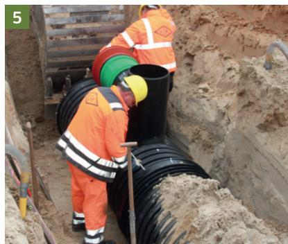
5 Mithilfe eines Baggers kann das Erweiterungsmodul nun in die Baugrube gelassen werden. Zum Verbinden schieben Sie nun das Modul mit der Muffe vorsichtig auf das Spitzende des Zulaufmoduls.
