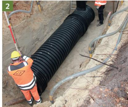
2 Die Verlegung und Bettung der Bauteile erfolgt nach DIN EN 1610. Es ist mindestens eine 10 cm dicke und verdichtete Sauberkeitsschicht vorzubereiten.
