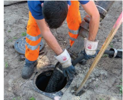
Die auf der Rohrsohle zurückbleibenden Sedimente und auftreibenden Stoffe können dann, mittels üblicher Kanalspül- und Absaugtechnik, entfernt werden. Zum Spülen und Reinigen der Anlage ist mittels Spülschlauch oder Spüllanze die Anlage durch den Zulaufschacht mit Wasser zu spülen. Gleichzeitig wird das anfallende gelöste Sediment durch den Ablaufschacht abgesaugt und fachgerecht entsorgt.
