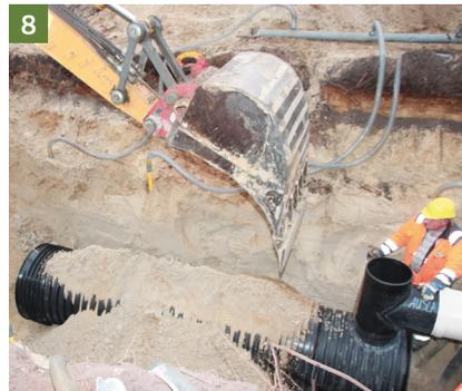
Die Seitenverfüllung, Überdeckung und Hauptverfüllung sind gemäss DIN EN 1610 auszuführen. Die Seitenverfüllung ist insbesondere im Kämpferbereich besonders sorgfältig mit leichtem Verdichtungsgerät durchzuführen.
