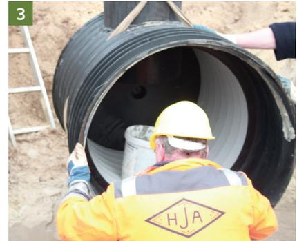
3 Die Bauteile sind mithilfe von Traggurten an den Halteösen in die Baugrube zu lassen und zu positionieren. Aus Sicherheitsgründen dürfen die Bauteile nur einzeln und ungefüllt transportiert werden.
