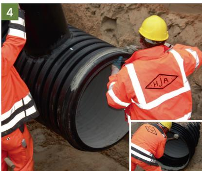
4 Zum Verbinden von Zulauf- und Erweiterungsmodul ist auf dem Spitzende des Zulaufmoduls der Dichtring zwischen erstem und zweitem Wellental einzulegen und Gleitmittel gleichmäßig aufzutragen.
