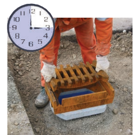
15. Minute: Aufsatz aufsetzen
