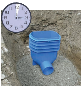
3. Minute: Schacht auf Magerbeton setzen
