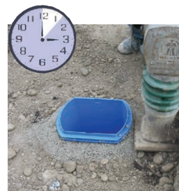
7. Minute: Verfüllen und verdichten
