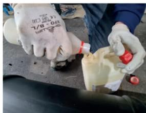
Beide Komponenten des Isoliersets im grossen Gebinde mischen und schütteln. Das Isolationsgemisch umgehend nach kompletter Vermischung in die zu isolierende Verbindung giessen. Achtung die Masse reagiert stark und entwickelt Wärme. Dabei sind Schutzhandschuhe und Schutzbrille zu tragen. (Montageanleitung beachten.)
