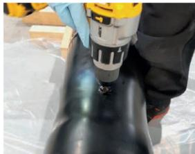
Für die nachträgliche Ausschäumung der Verbindung muss ein Loch mit einem Durchmesser von 22 mm, durch die Schrumpfmuffe, oben mittig gebohrt werden.
