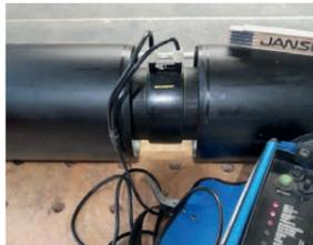
Das Mediumrohr mit Elektro-Schweissmuffe spannungsfrei verschweissen. Eine Dichtheitsprüfung sollte bei Bedarf zu diesem Zeitpunkt durchgeführt werden. Danach ist die Schweissverbindung schlecht zugänglich.
