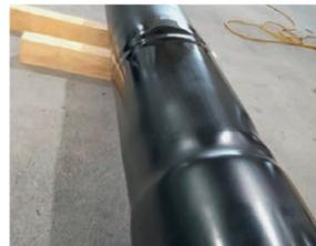
Schrumpfmuffe an Schutzrohr ist gleichmässig angepasst. Vor dem nächsten Schritt muss die Muffe komplett ausgekühlt sein.
