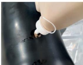
Nach vollständiger Expansion des Schaumes, der durch das Loch austreten soll, kann dieses mit einem PE-Verschlusszapfen und Hammer verschlossen werden.
