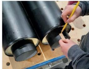
Mediumrohr zur Heizwendel-Schweissung vorbereiten und die Schrumpfmuffe aufbringen.
