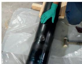
Die Arbeiten sind vollständig abgeschlossen und die Rohrverbindung ist isoliert und kann belastet werden.
