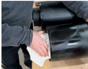
Das Mediumrohr / Schutzrohr sauber reinigen. Die Schweissstelle mechanisch bearbeiten (schaben).
