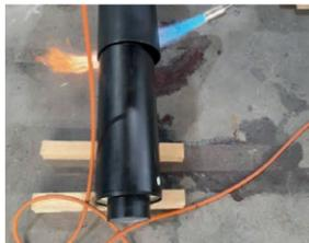
Die Schrumpfmuffe wird mit dem Brenner von unten nach oben geschrumpft. Dabei ist darauf zu achten, dass die Wärme gleichmässig verteilt und keine Verbrennung des Materials verursacht wird.
