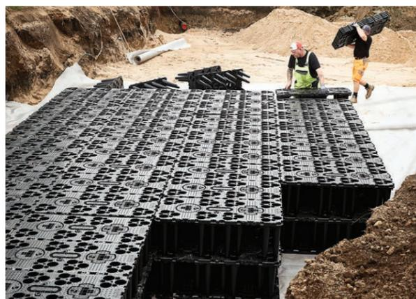
Grazie al suo design modulare, è possibile adattare perfettamente il canaletto, in termini di forma e allineamento, alle condizioni del luogo, senza variazioni nell'efficienza del deflusso regolato/filtraggio.
