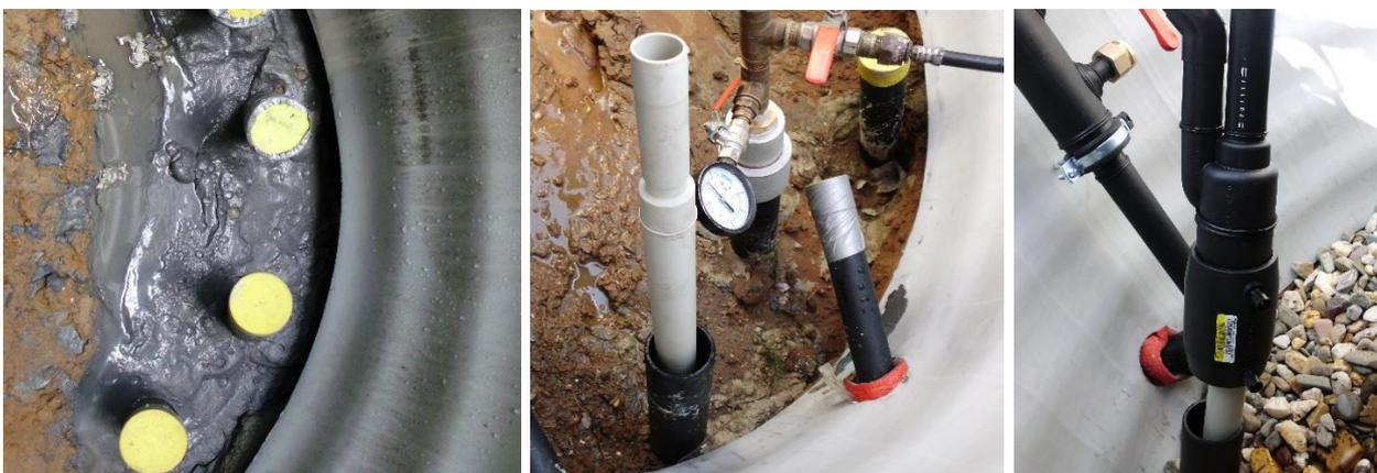
Abb. 11: JANSEN powerwave coax in der Basisvariante „Standard“ mit GRD-Schrägb Bohrverfahren in einem Schacht; Links: Schritt 1: 4 Bohrungen mit eingebauten Außenrohren, mittels Schutzkappen verschlossen; Mitte: Schritt 2: in Sonde Nr. 1 wird das Innenrohr eingeschoben, auf Sonde Nr. 2 läuft eine Druckprüfung; Rechts: Schritt 3: der Koaxial-Sondenkopf wird mit dem Innenrohr verbunden und mittels E-Muffe aufs Außenrohr geschweißt
