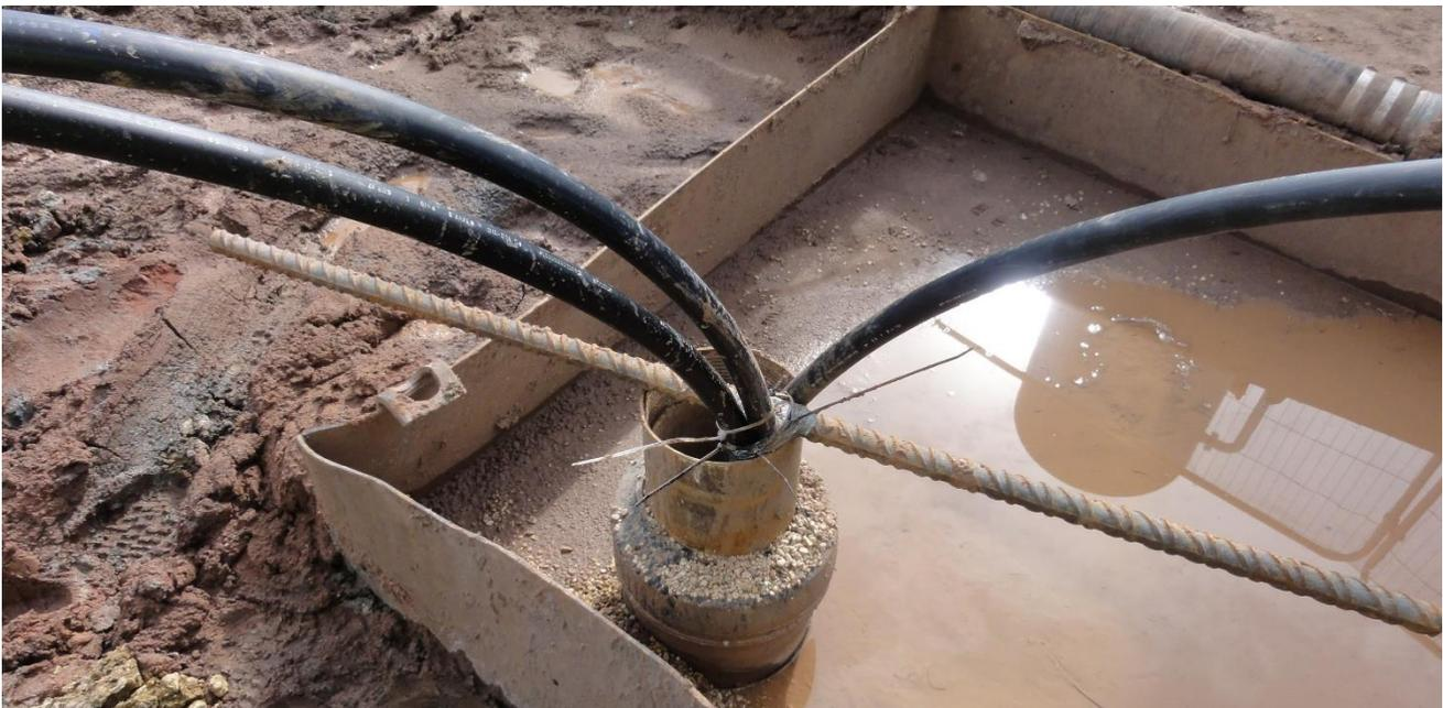
Abb. 16: Eine der 50 JANSEN powerwave coax. Der Kunde verbaute die komplett vorkonfektionierte Variante. Es blicken die zwei 32-mm-Anschlussrohre sowie das Injektionsrohr aus dem Bohrloch.
