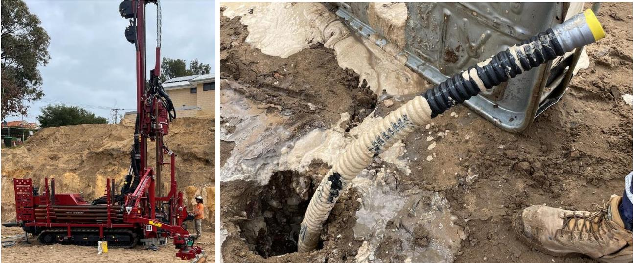
Abb. 17: Links: Bohrung mittels „SonicSampDrill“, im Hintergrund ist ein Schnitt durch den weichen Kalkstein zu sehen, in den gebohrt wurde; Rechts: eingebautes Außenrohr der JANSEN powerwave coax Standard-Variante. Im Zuge der Erstellung der Verbindungsleitungen wird dann auch das Innenrohr eingebracht und der Sondenkopf angeschweißt.
