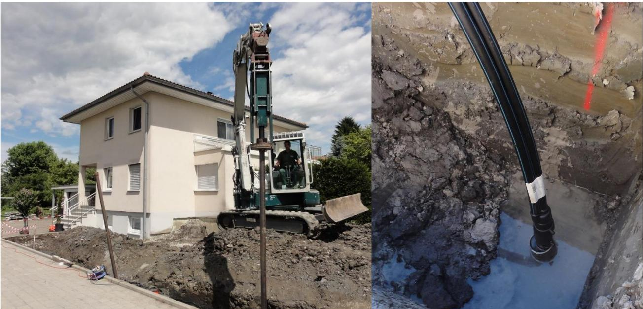
Abb. 13: Links: Einrammen von Stahlrohren; Rechts: das Stahlrohr wird anschließend mit einer flüssigen Hinterfüllsuspension auf ein zuvor berechnetes Niveau befüllt und dann die JANSEN powerwave coax eingestoßen.
