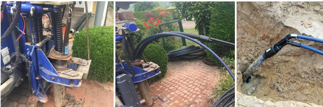
Abb. 18: Links & Mitte: Kontrollierter Einbau der Komfortvariante; Rechts: Fertig angeschlossene Erdwärmesonde, hier in der Basisvariante mit Sondenkopf mit abgewinkelten Anschlussrohren; Fotoquelle: Kunkel Spezialtiefbau
