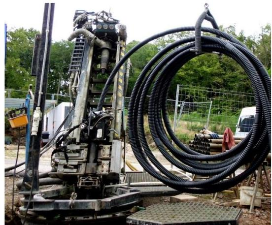
Abb. 14: Einbau mittels GRD-Schrägbohrverfahren
