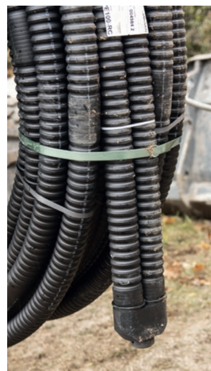
Abb. 4 – Die Erdwärmesonde nach der Anlieferung
