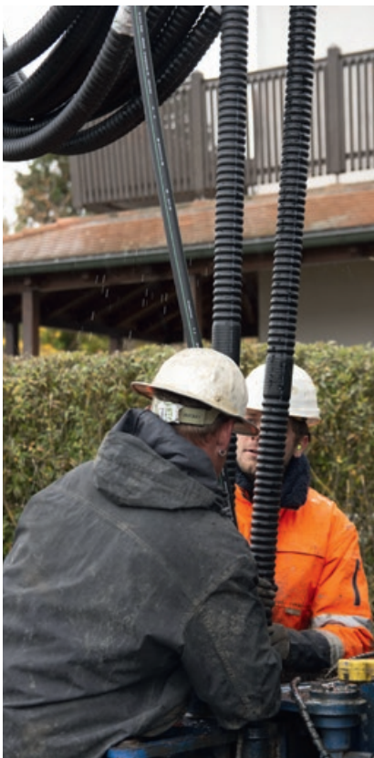
Abb. 5 – Alle 100 cm ist ein Glattröhsegment integriert (mittig im Bild erkennbar), das ein flexibles Anpassen der Sondenlänge und eine sichere Verbindung durch handelsübliche Elektroschweiß-Fittings mit den Verbindungsleitungen erlaubt.
