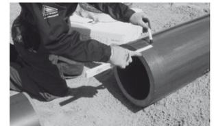
Danach das Spitzende mit Gleitmittel bestreichen und die VPC-Rohrkupplung auf das Rohr mit der größeren Nennweite aufsetzen.
