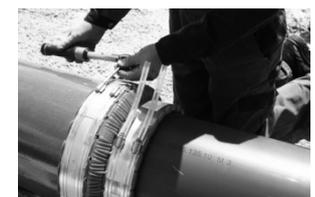
Anschließend werden die beiden Spannschlösser abwechselnd festgezogen. Dieser Vorgang wird beim Einbinden des kleineren Rohres entsprechend wiederholt. Hierfür das anzuschließende Rohr in Höhenlage bringen, damit die VPC-Rohrkupplung entlastet ist.
