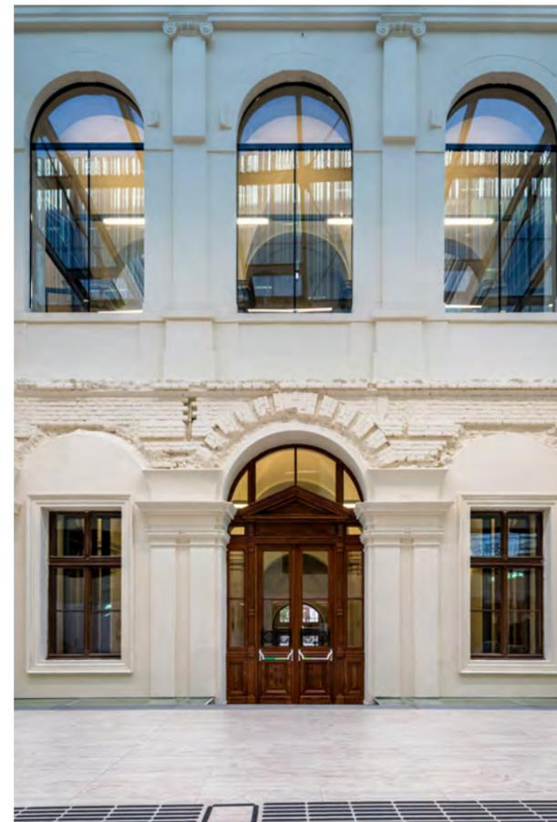
Für Türen und Fenster wurde auf dem neuen Uni-Campus das hochwärmegeämmte System Janisol HI verbaut. Ebenfalls zum Einsatz kamen die Brandschutztüren Janisol C4 EI60 und Janisol 2 EI30.
