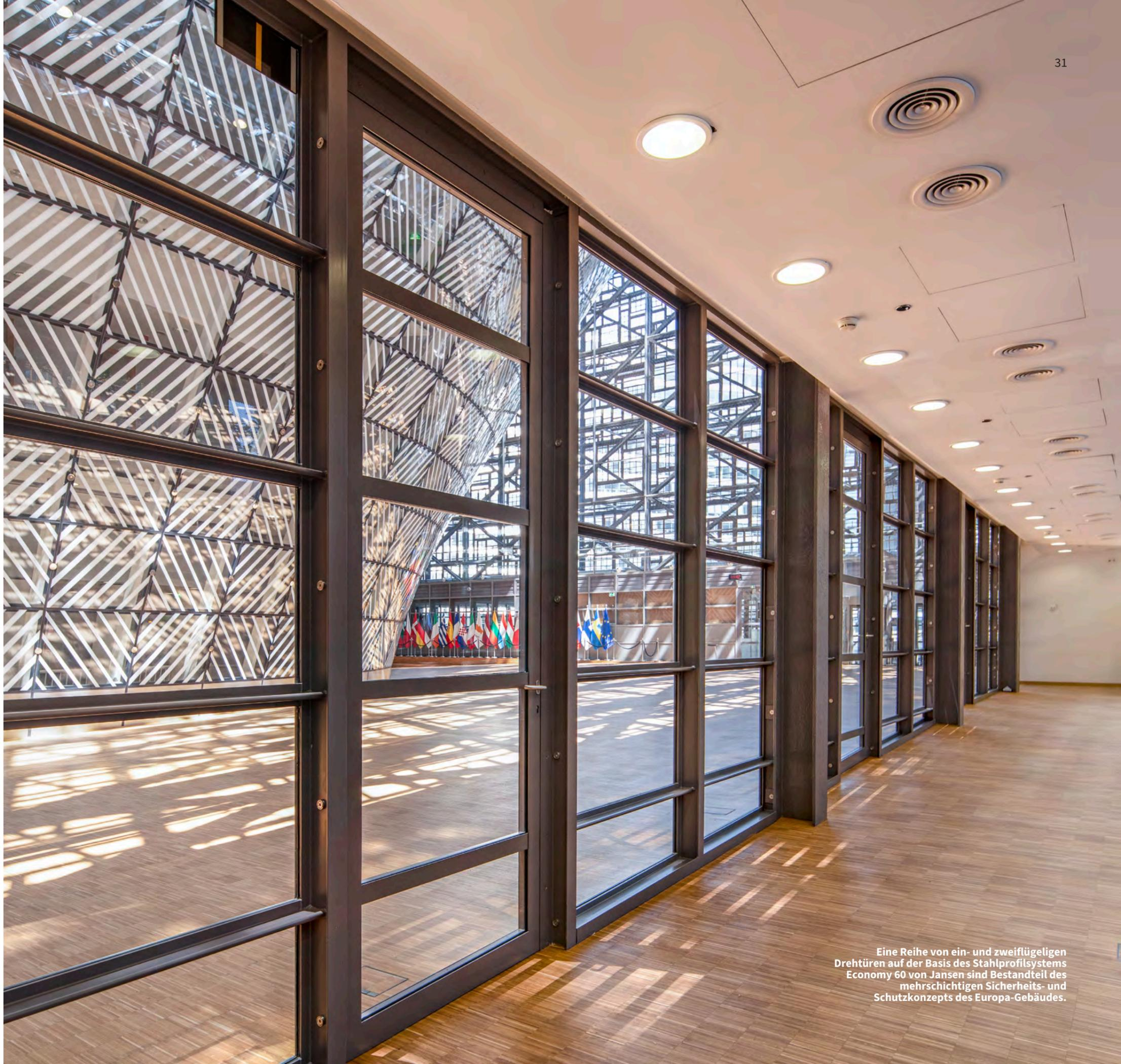
Eine Reihe von ein- und zweiflügeligen Drehtüren auf der Basis des Stahlprofilsystems Economy 60 von Jansen sind Bestandteil des mehrschichtigen Sicherheits- und Schutzkonzepts des Europa-Gebäudes.
