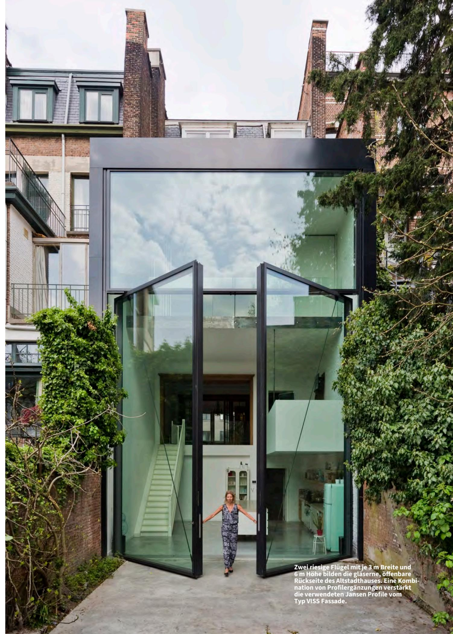
Zwei riesige Flügel mit je 3 m Breite und 6 m Höhe bilden die gläserne, offenbare Rückseite des Altstadthauses. Eine Kombination von Profilergänzungen verstärkt die verwendeten Jansen Profile vom Typ VISS Fassade.
