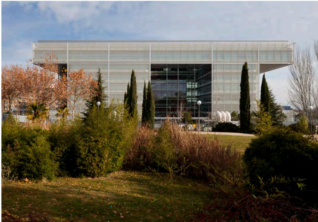
Die keramische Beschichtung der Solarreflektor-Rohre vor den Aussenfassaden fängt Licht ein und reflektiert es mit gedimmter Helligkeit ins Gebäudeinnere.
