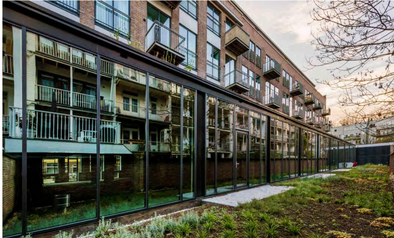
Die rückseitige Glasfassade im Erdgeschoss entspricht der Brandschutzanforderung G30. Die Architekten wählten hierfür das Stahlprofilssystem Jansen VISS. In den darüberliegenden Etagen sorgen bodentiefe Drehkippenster aus Janisol Arte 66 für eine wohnliche Atmosphäre.
