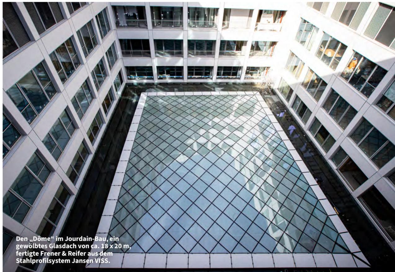
Den „Dôme“ im Jourdain-Bau, ein gewölbtes Glasdach von ca. 18 x 20 m, fertigte Frener & Reifer aus dem Stahlprofilssystem Jansen VISS.
