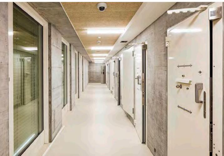
Gut einsehbare Korridore mit ausbruchssicheren Festverglasungen sorgen für die gewünschte Übersicht, während Türen aus Janisol 2 EI30 die Zellen sichern.
