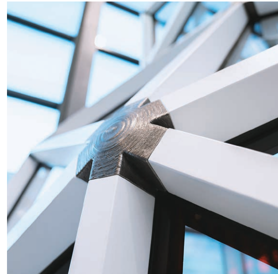
VISS 3 3D-geprinte stalen knooppunten
