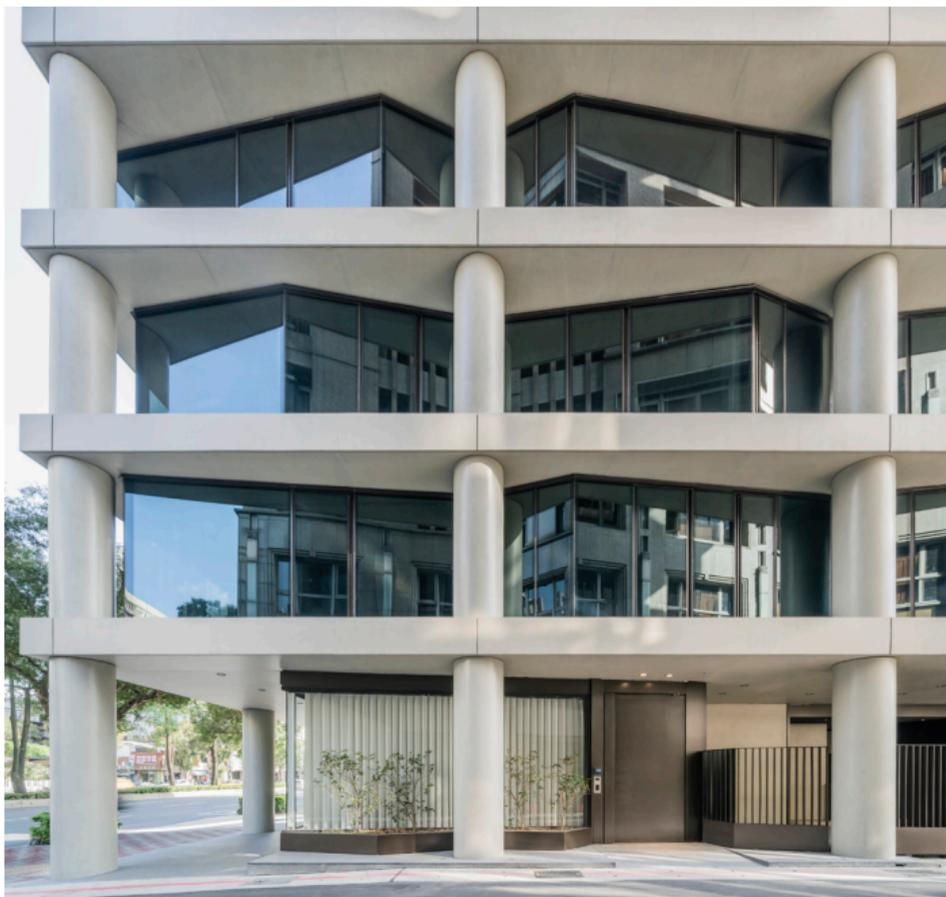
Der besondere Stil des ikonischen Bauwerks resultiert aus dem Kontrast zwischen der erdbebensicheren Struktur und der feingliedrigen Struktur der polygonalen Glasfassade. Die Realisation mit dem Stahlsystem VISS Semi SG von Jansen AG erwies sich als anspruchsvoll.
