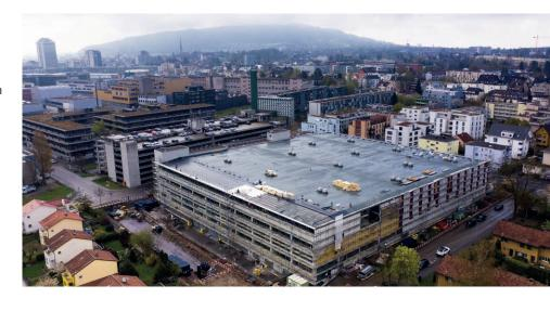
Mengen von Regenwasser, könnte von der Kanalisation nicht aufgenommen werden. Das erbaute Speichervolumen ermöglichte die Bildung eines Puffer/ Stauraums für das Regenwasser, daraus resultierend wird das Regenwasser dosiert in die Kanalisation abgeleitet.
